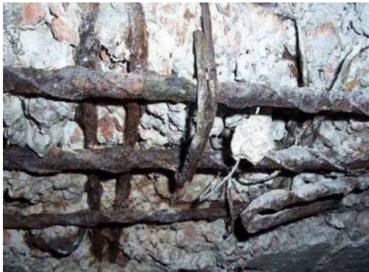
Figura 13: Corrosión.
