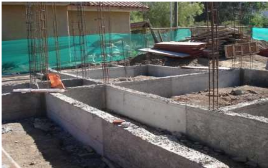
Figura 04: Cimentación y sobrecimiento
