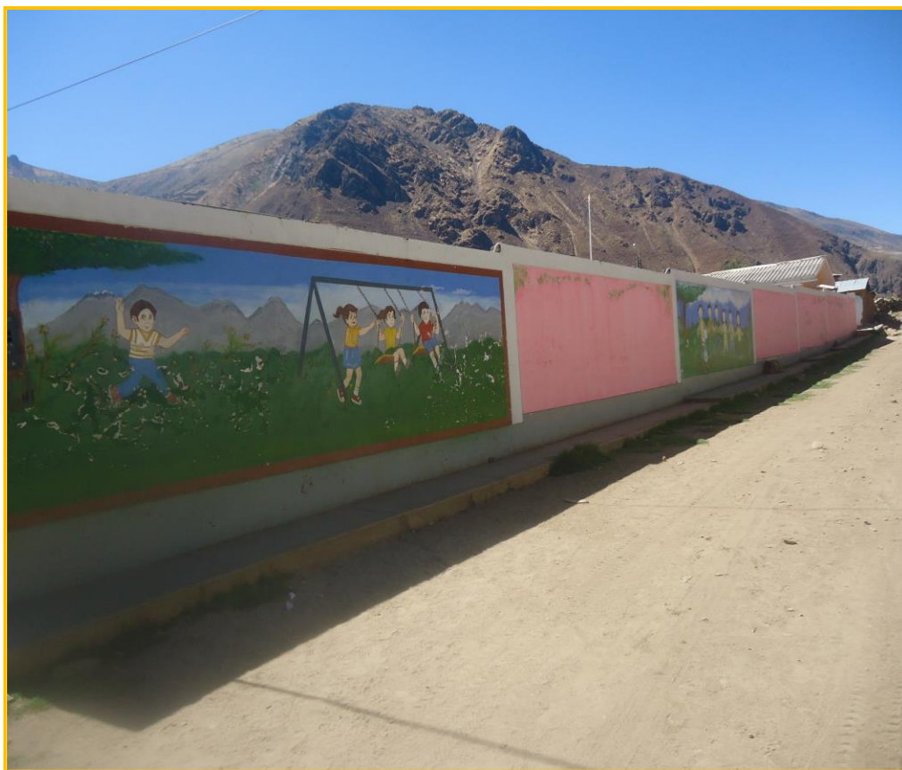
Vista del lado este del cerco perimétrico
