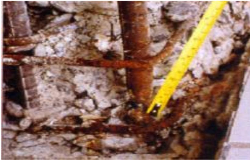
*Figura 13. Corrosión*
