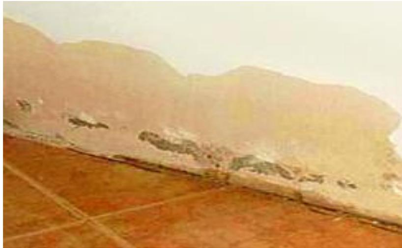
*Figura 14.* Eflorescencia paredes.
