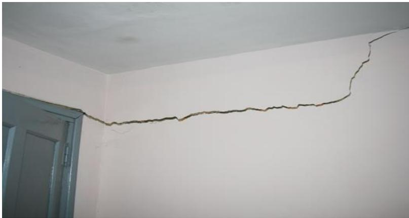
*Figura 10. Grieta de muros*
