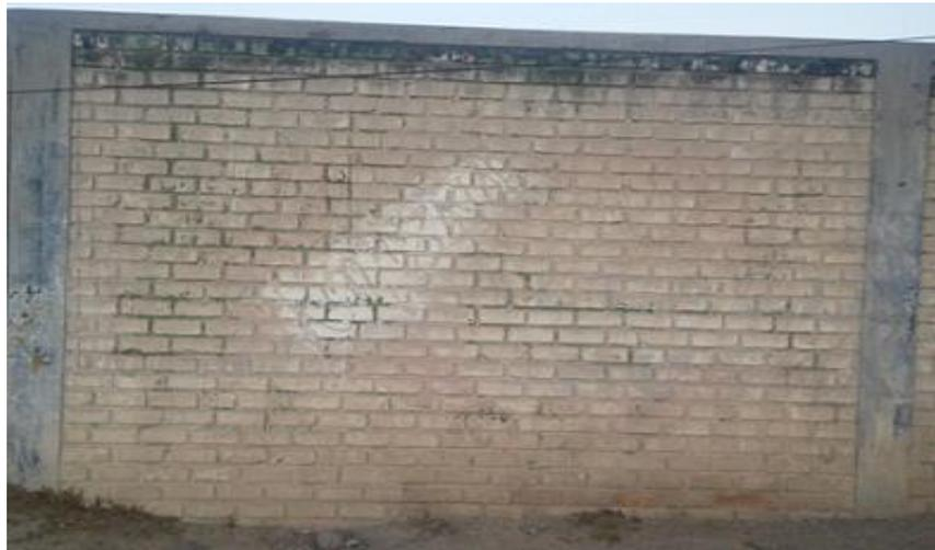
*Figura 01.* Estructura de albañilería confinada
