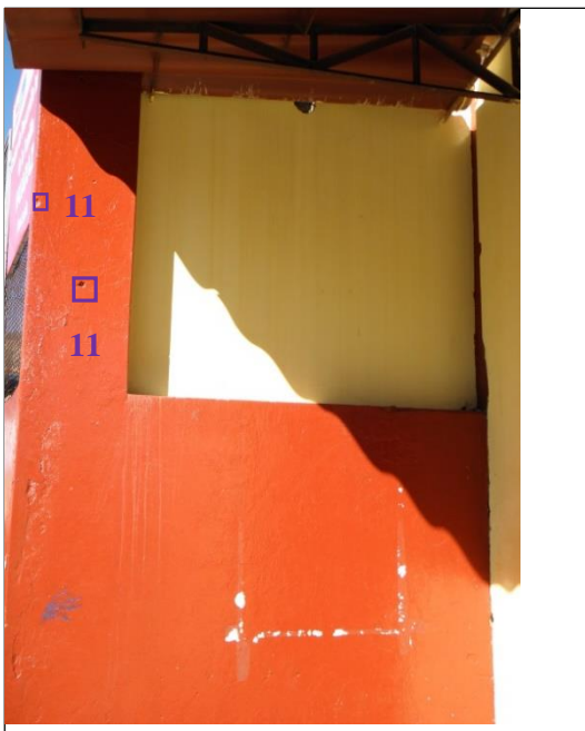
Fotografía 08: Picaduras a nivel e columnas.
