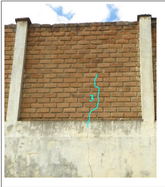
Fotografía 07: Fisuras y grietas en muros.
