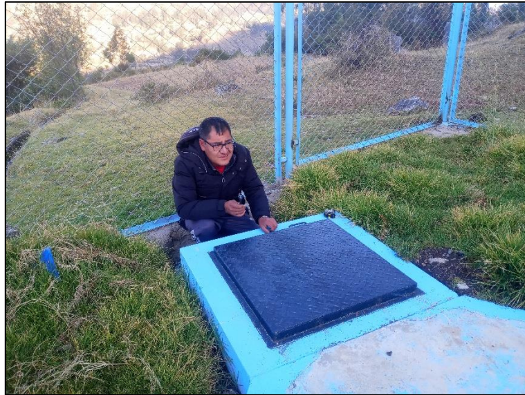
Fotografía N° 1 Vista de la captación
