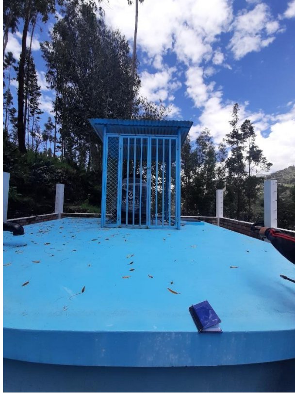
Fotografía N° 5 Vista del reservorio
