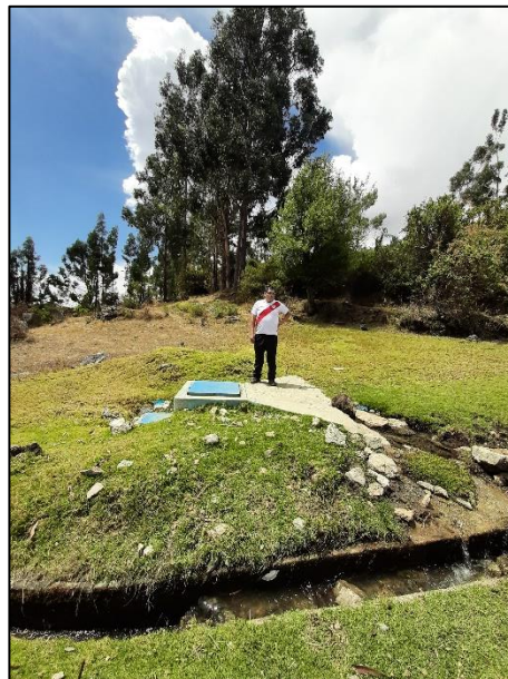
Fotografía N° 1 Vista de la captación antes del mantenimiento
