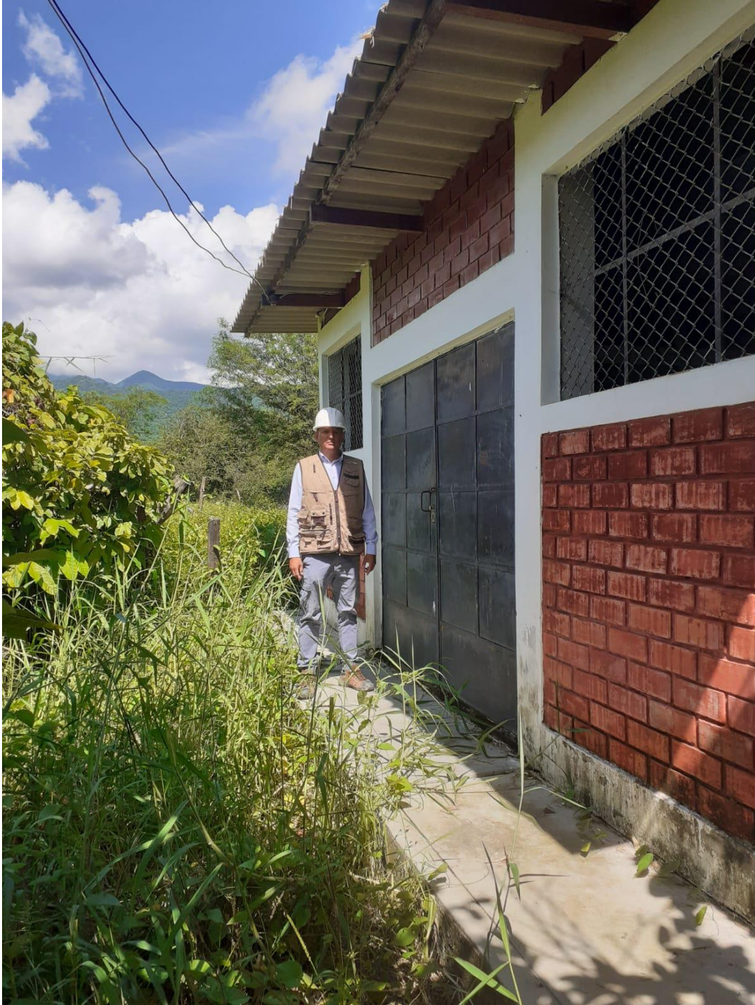
Imagen 13: Cuarto de Captación subterránea
