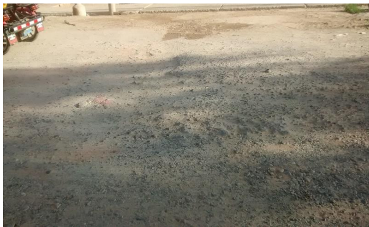
Imagen 6. Depresiones en la superficie del pavimento
