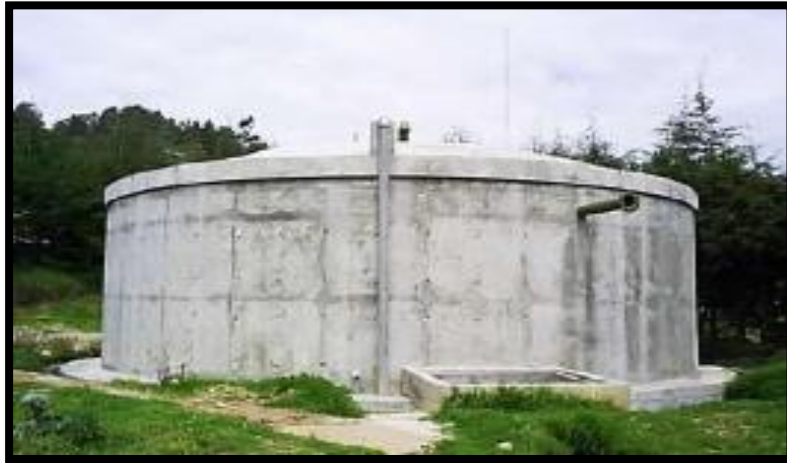
Imagen 2 Reservorio apoyado de forma circular
