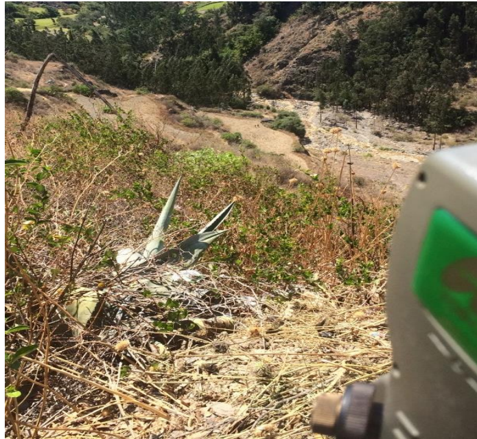
Fotografía 05: Levantamiento topográfico de la línea de conducción
