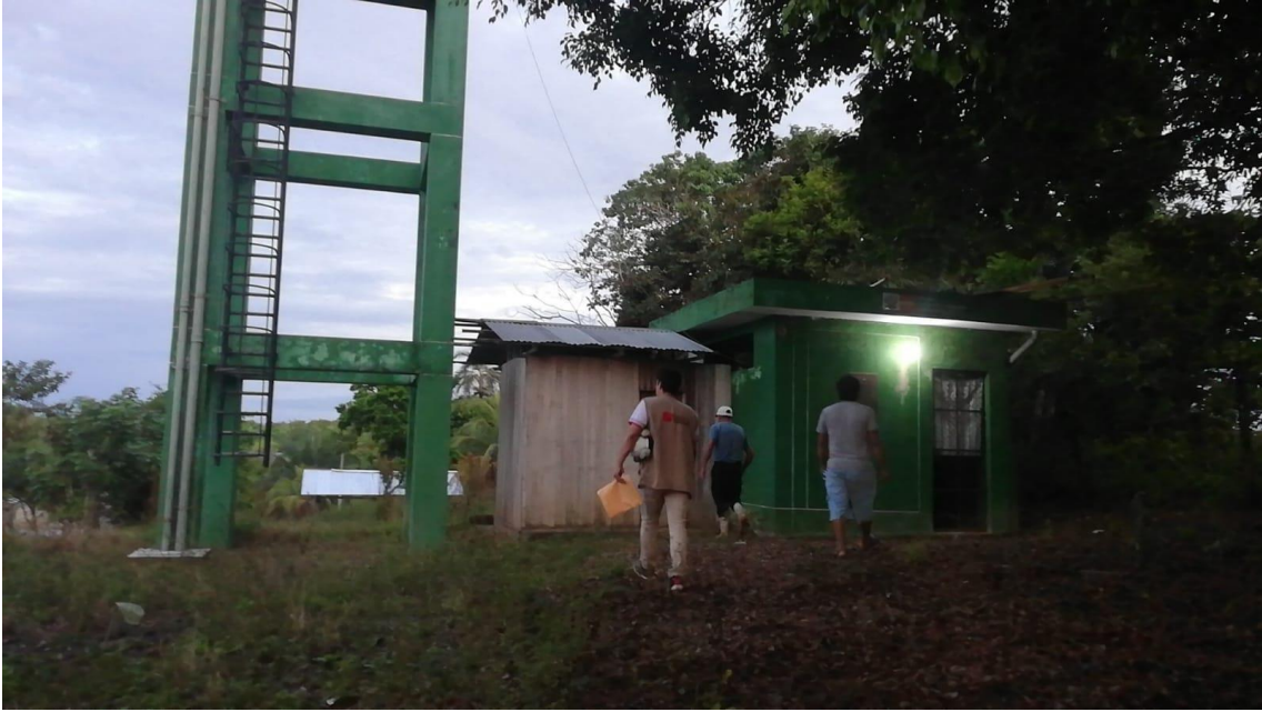
Imagen 3: Reservorio elevado, caseta de cloración y caseta de control
