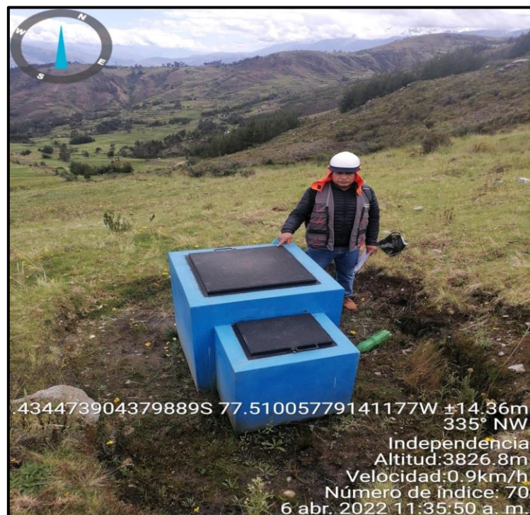
Imagen 17: Primera Cámara de captación del centro poblado Chavín
