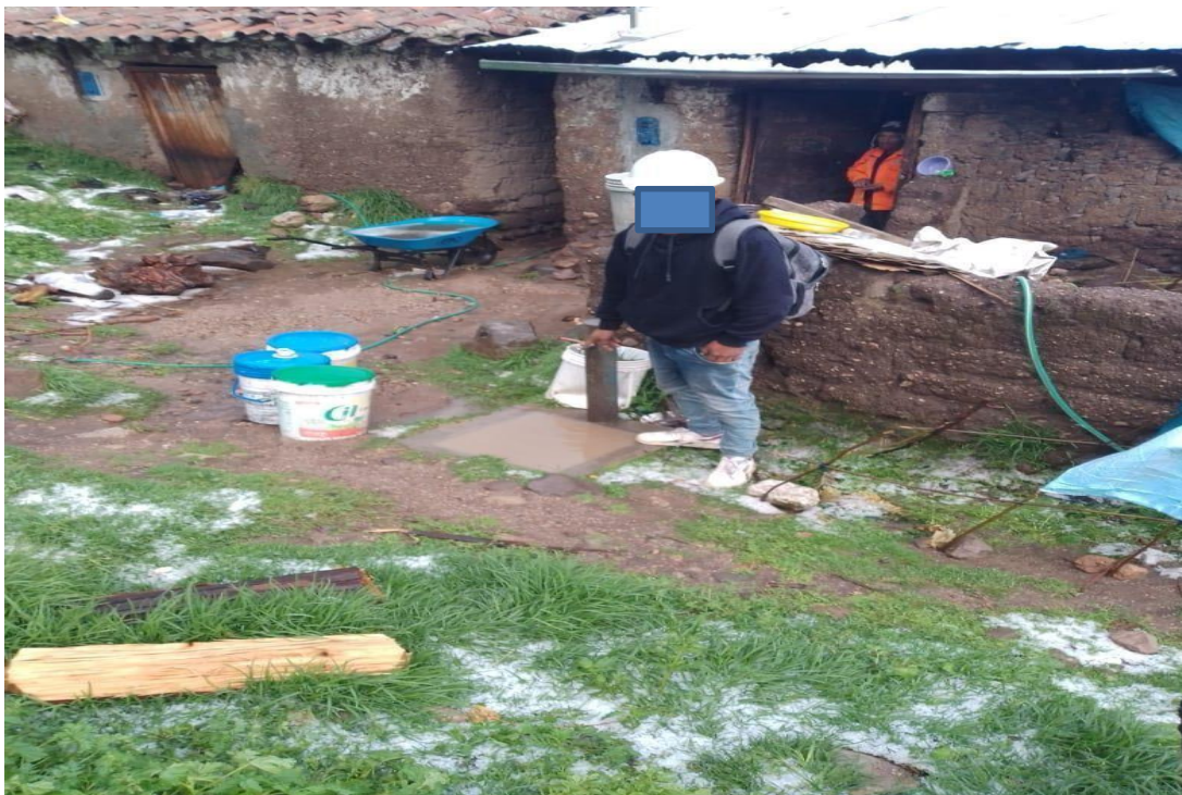
Foto 10. : Instalaciones domiciliarias puntos de grifos . Fuente: Producción propia
