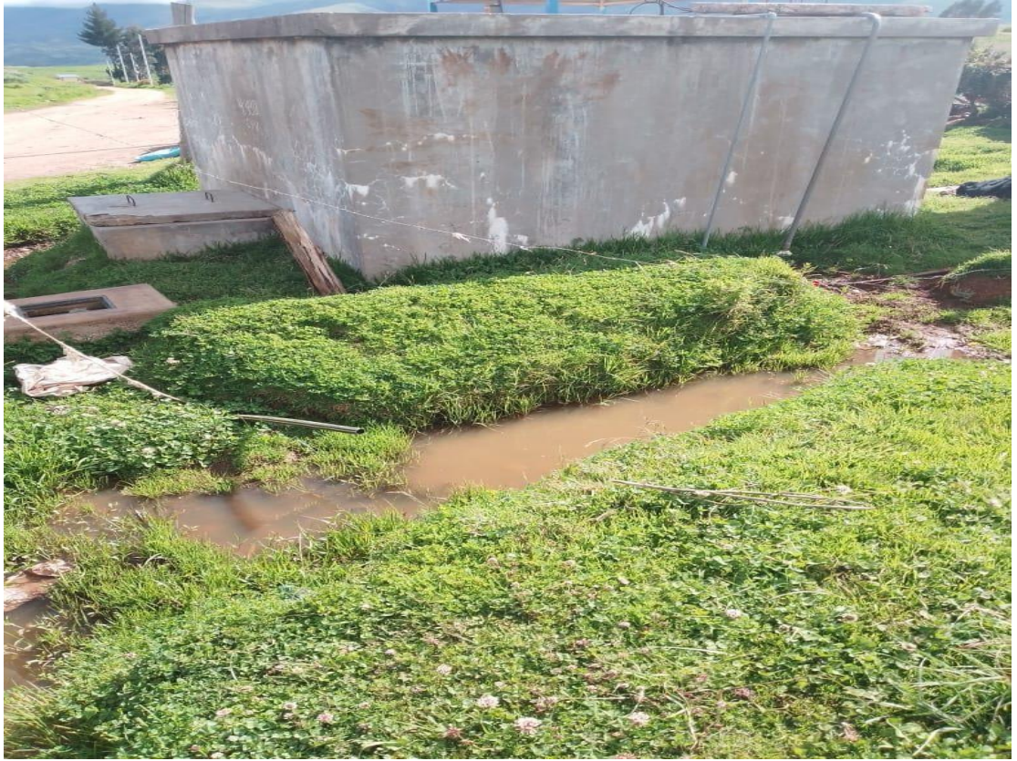
Foto 7 : Reservorio por el alrededor con humedales .
