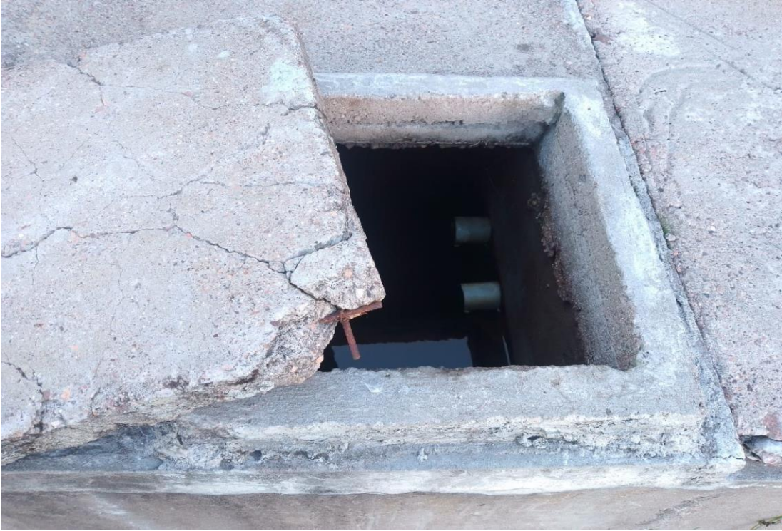
Foto 2. : Tipo ladera captación. Fuente: Producción propia
