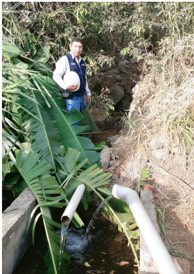
Imagen 13: Cámara de Captación del centro poblado kilómetro 24
