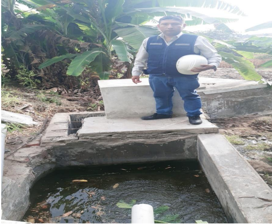
Imagen 14: Estado de la captación
