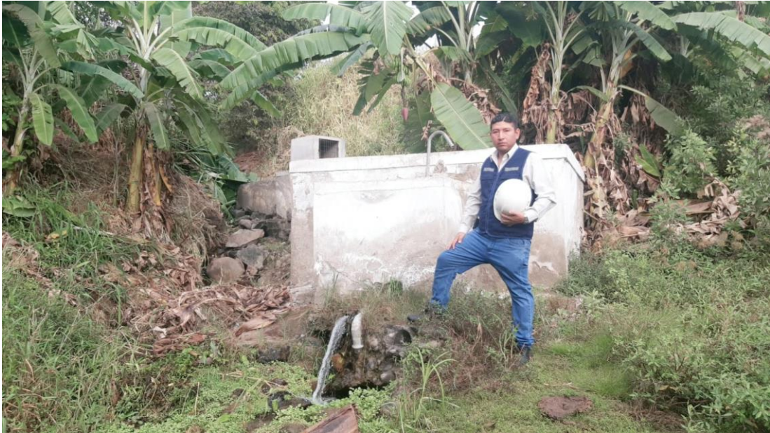
Imagen 15: Reservorio del centro poblado kilómetro 24
