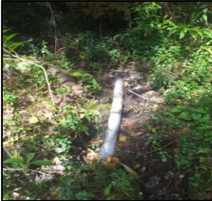
**Fotografía 03:** Tubería de conducción expuestas a la intemperie de agua potable del Caserío de Shumay, Marcará, Carhuaz, Ancash
