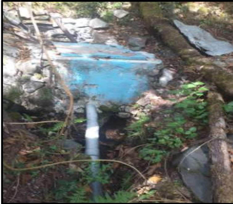
**Fotografía 01:** Captación, de agua potable del Caserío de Shumay, Marcará, Carhuaz, Ancash
