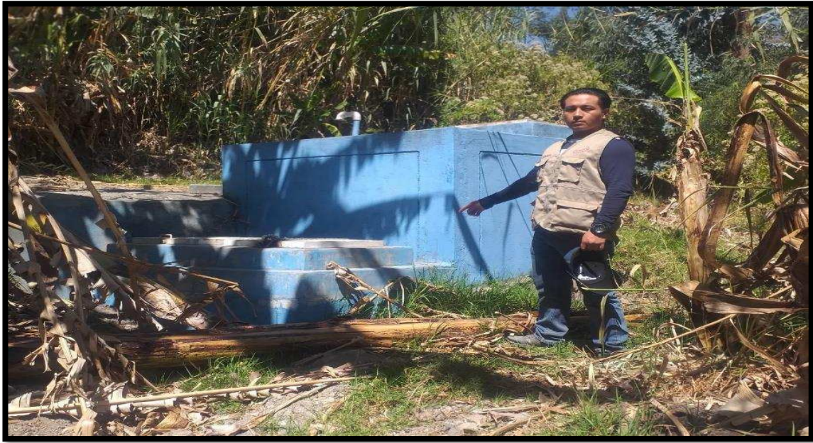
Imagen 03: Captación del sistema de abastecimiento de agua potable del Barrio Allauca, distrito de Caraz, provincia de Huaylas, región Áncash – 2023.
