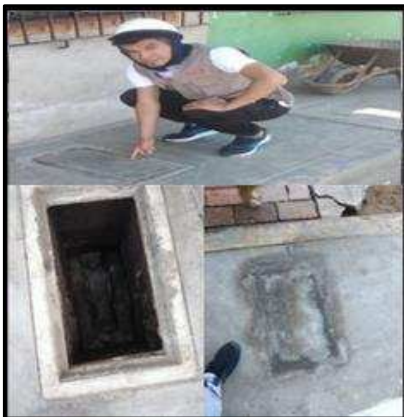
Figura 59: Evidencia de la evaluación de las conexiones domiciliarias
