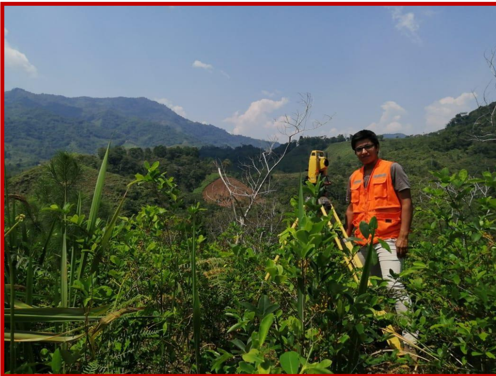
Figura 25 Levantamiento topográfico de la línea de Conducción
