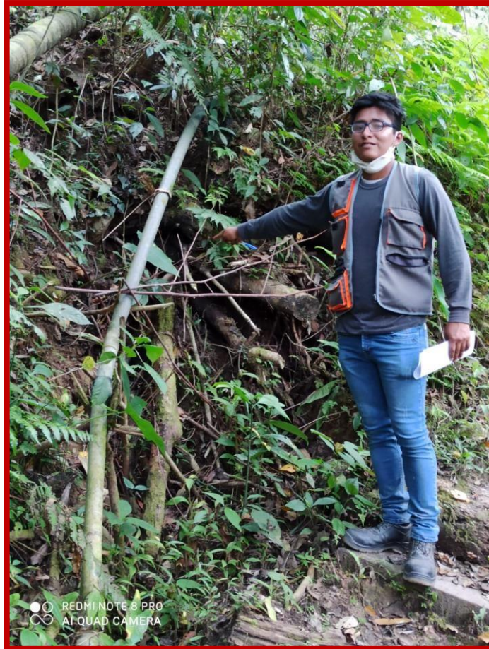
Figura 28 Línea de Conducción en mal estado
