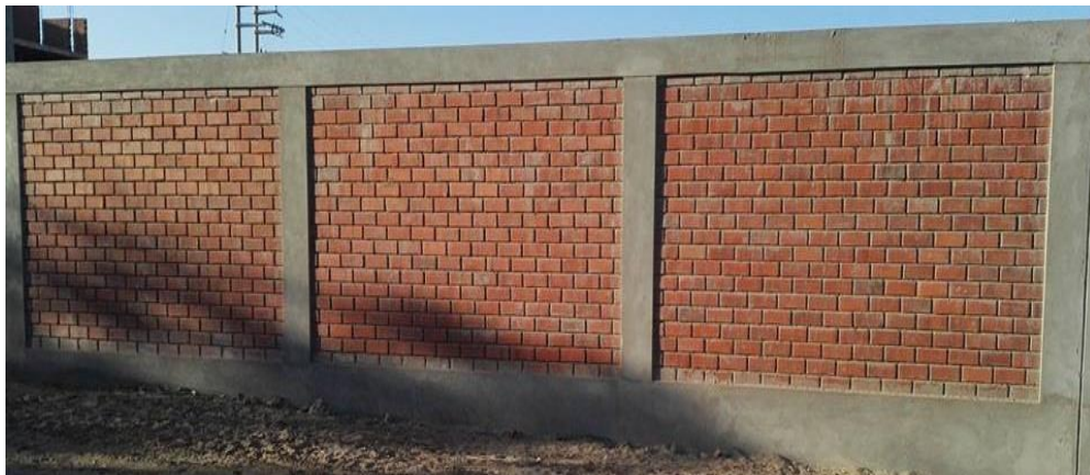
Figura 1. Cerco perimétrico de albañilería confinada.
