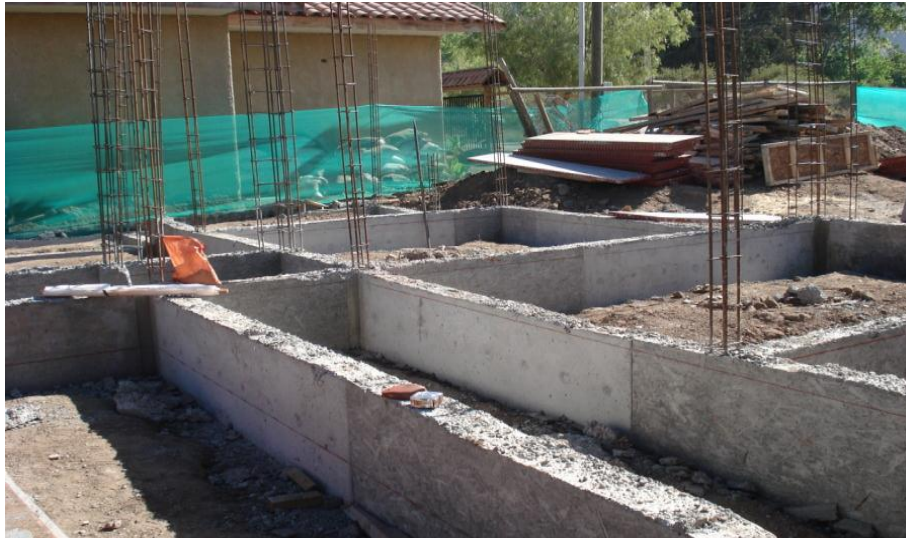
Figura 3. Sobrecimiento de concreto simple. Nota. Fuente: Rojas, E. (2016).
