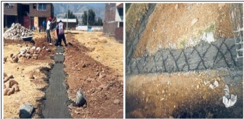
Figura 2. Cimentación de concreto simple.
