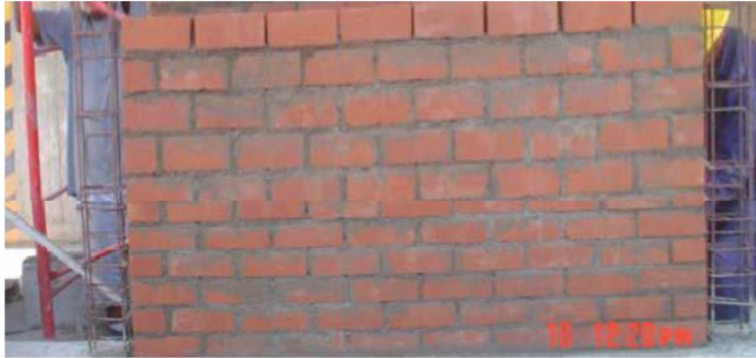
Figura 6. Muro de albañilería con ladrillos de arcilla.
