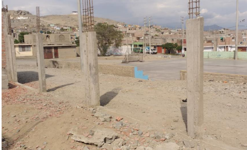
Figura 4. Columnas de concreto armado. Nota. Fuente: Lector A. (2016)
