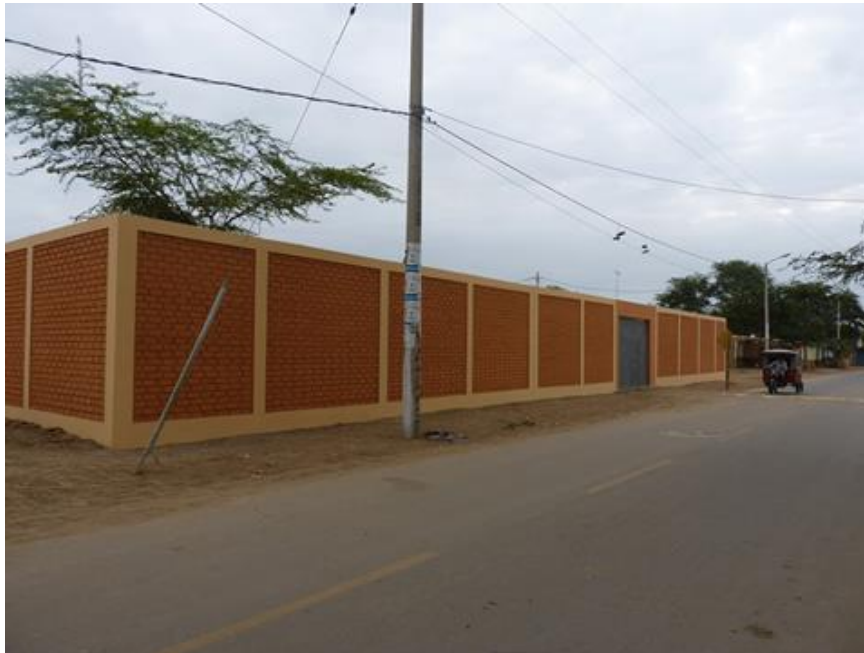
Figura 15. Vista panorámica de un cerco perimétrico de albañilería confinada. Nota. Fuente: Contreras, O. (2016).
