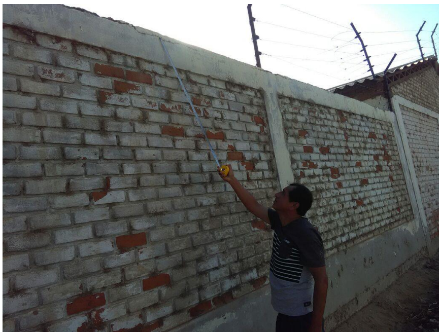
Gráfico 46: Presencia de fisuración en la viga
