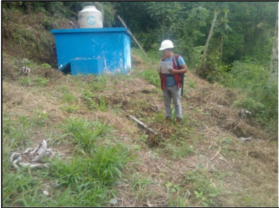
Foto 7: Evaluando la línea de aducción existente del centro Poblado Huantinini
