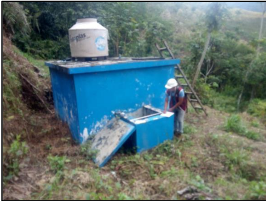
Foto 5: Evaluando el reservorio existente del centro Poblado Huantinini
