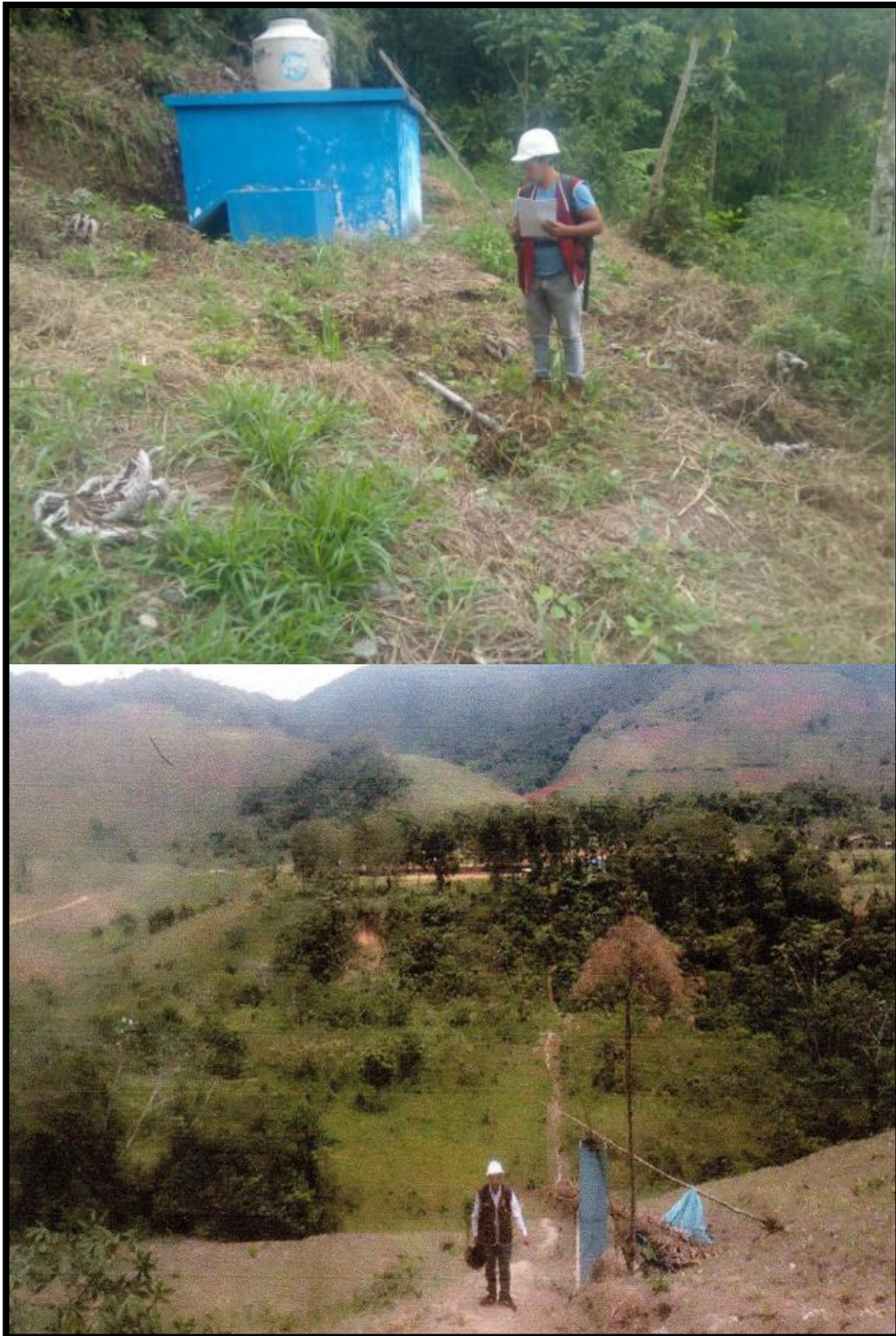
Imagen 4: Línea de “aducción”
