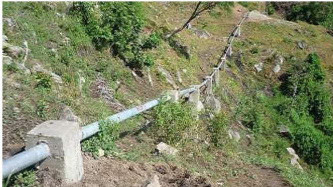
**Figura 6:** Línea de conducción
