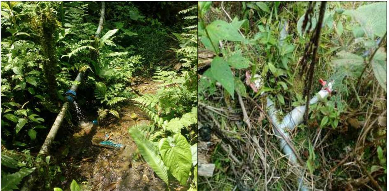
**Figura 36:** Tuberías de expuestas de la línea de conducción
