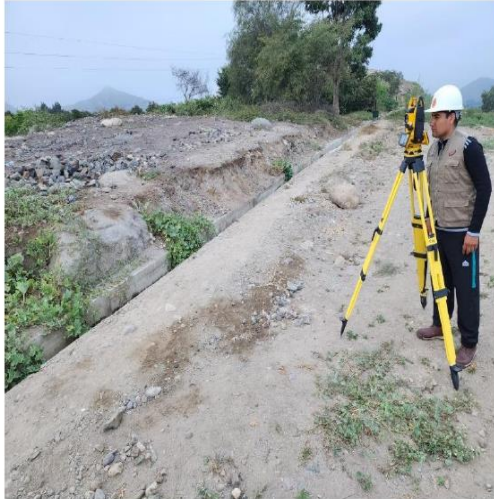
FOTO N° 03: LEVANTAMIENTO TOPOGRAFICO DE LA LINEA DE CONDUCCION EN LA LOCALIDAD DE SAN PEDRO.
