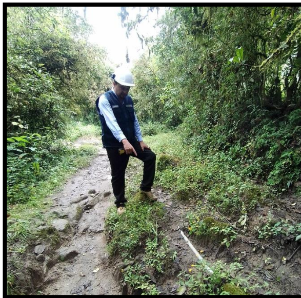
Figura N° 37 Red expuesta a posibles roturas
