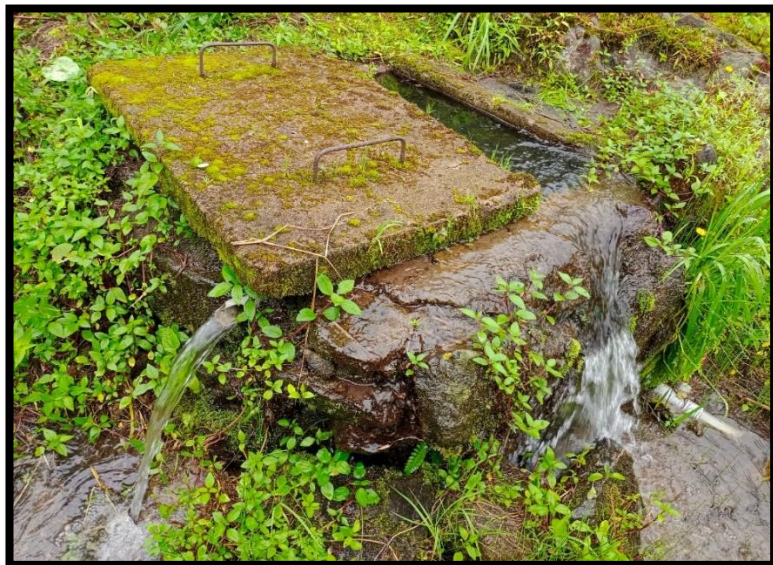
Figura N° 25 Tapa de concreto
