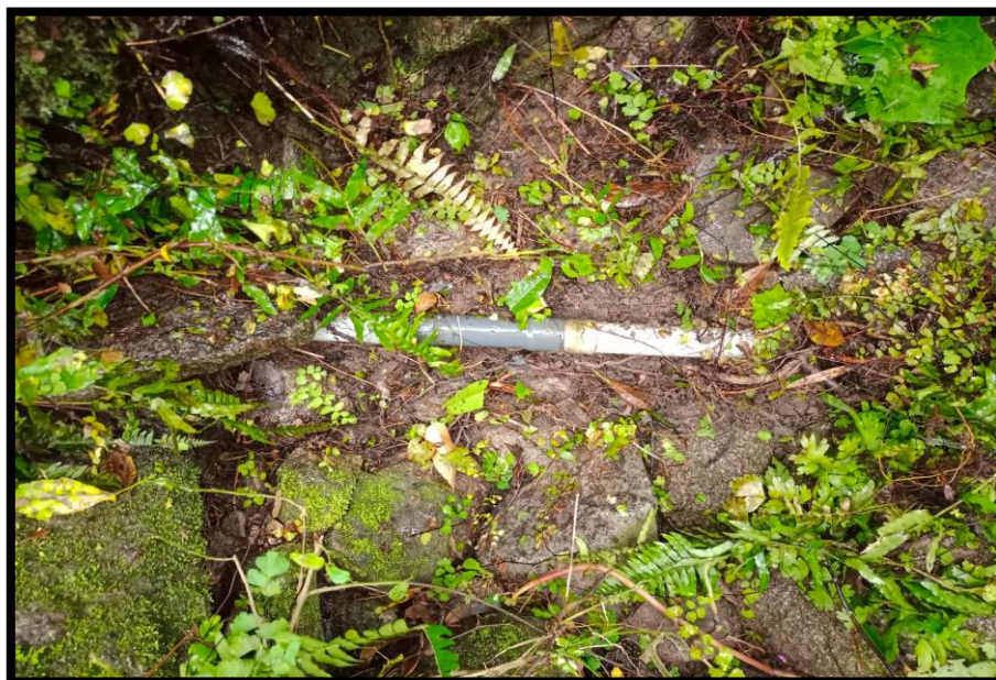
Figura N° 27 Reparaciones en la Red
