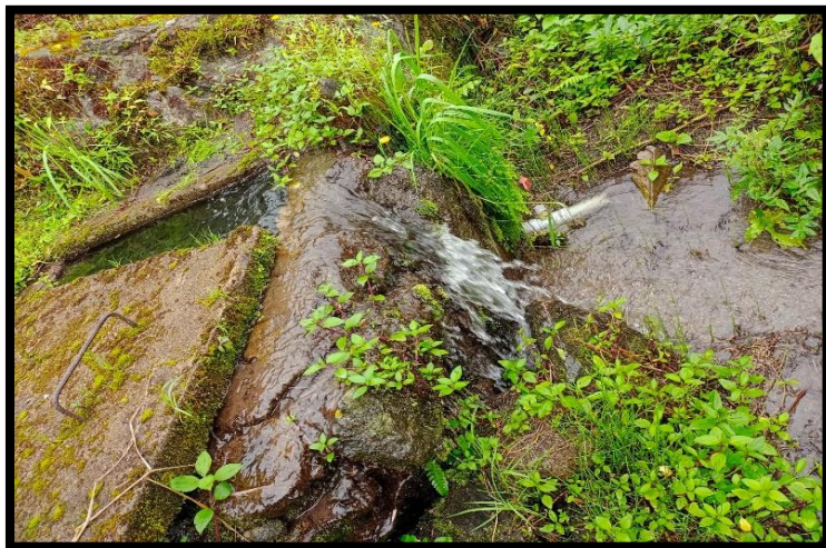
Figura N° 26 Tapa de concreto
