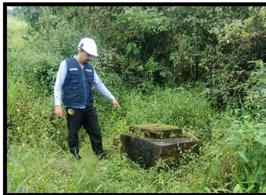
Figura N° 38 Cámara rompe presión
