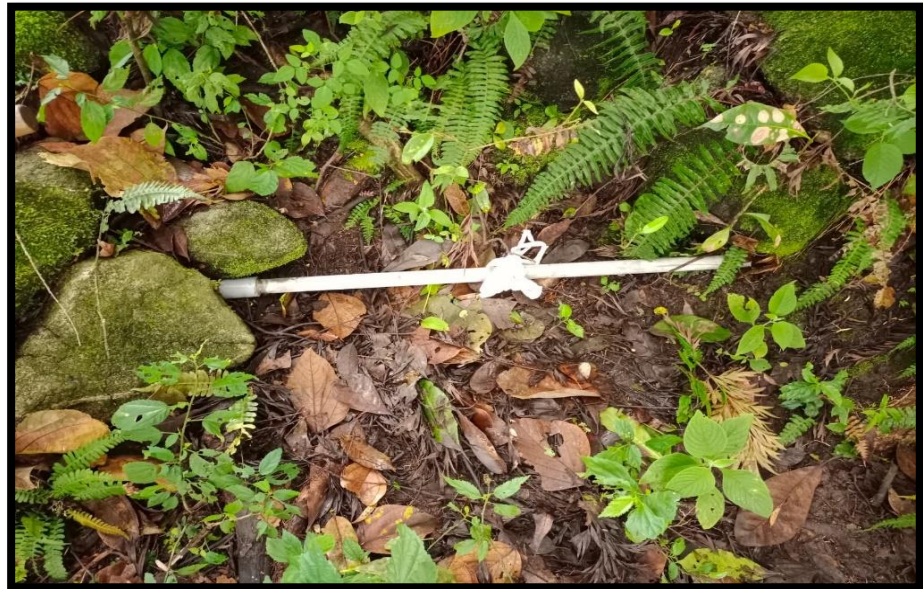
Figura N° 28 Tramos de tubería reparados
