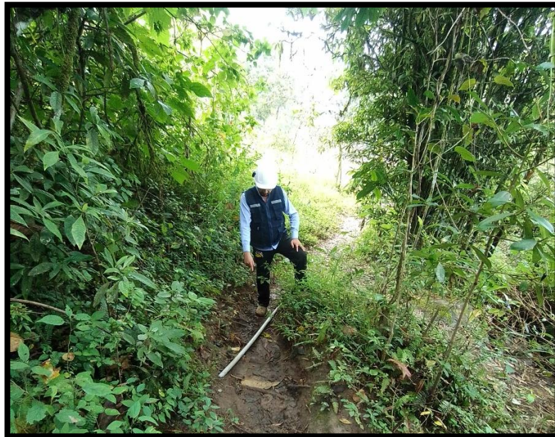
Figura N° 36 Red expuesta en camino
