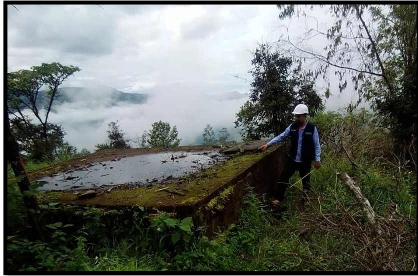
Figura N° 33 Reservorio apoyado de concreto armado
