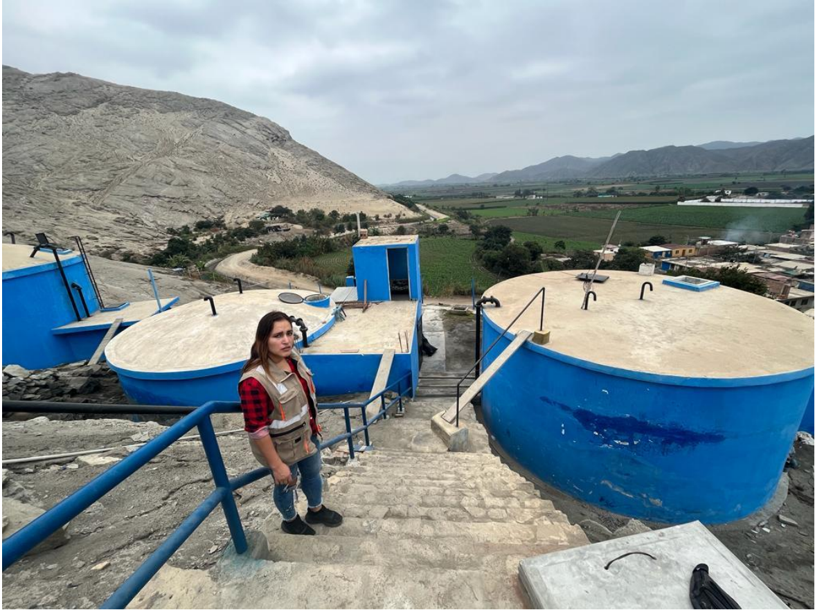
Figura 14: Reservorio del anexo de Ramballay
