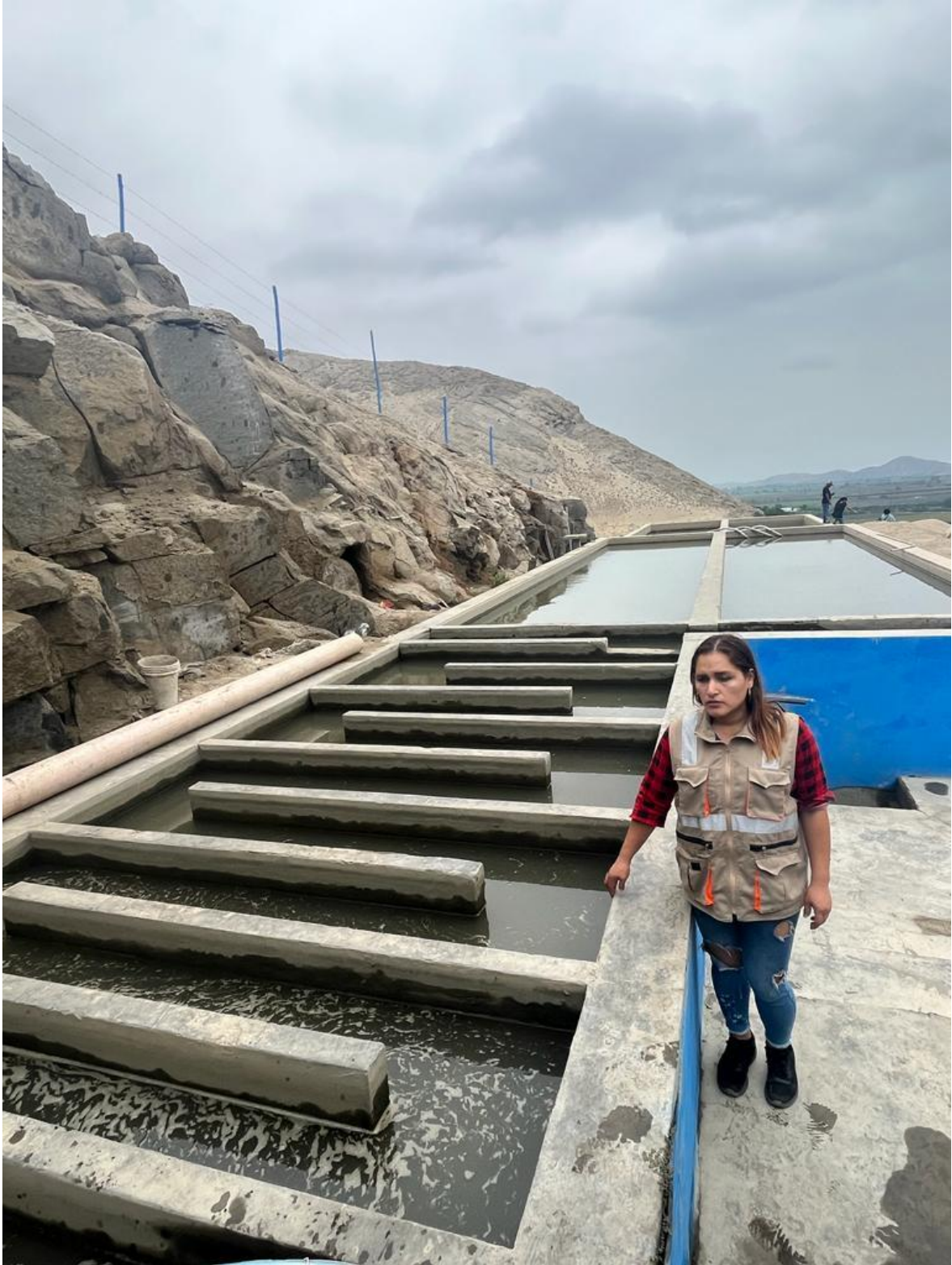
Figura 10: Sistema de desarenador
