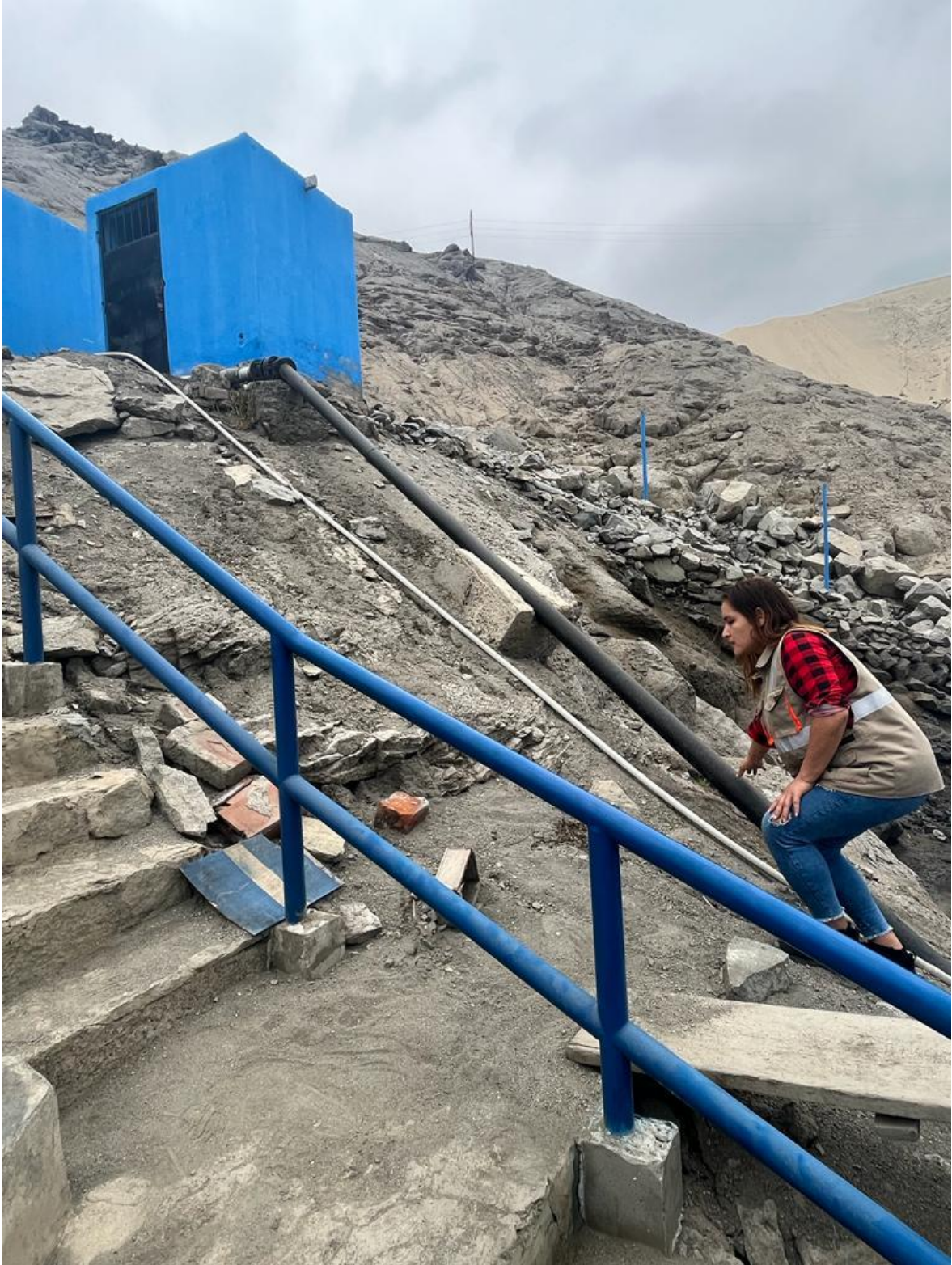
Figura 9: Línea de conducción
