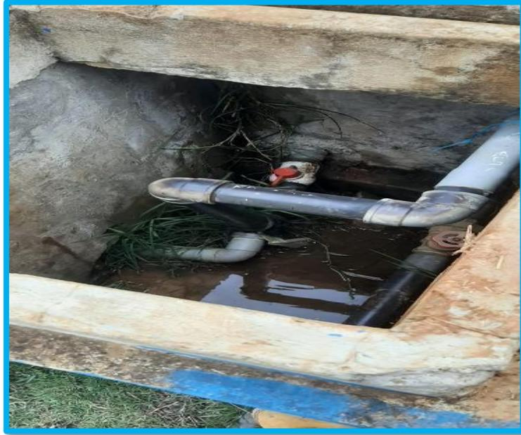
FOTO 3: Las válvulas del reservorio
