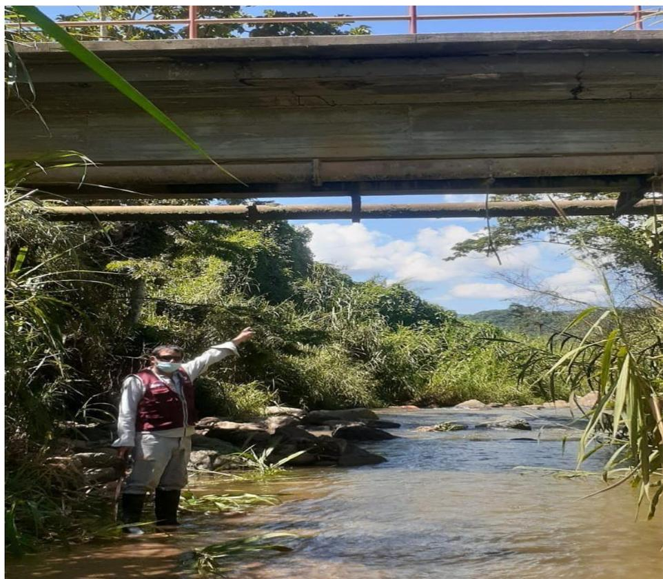
**Foto 08:** Tubería matriz izquierda de agua bajo el puente Timarini 1
