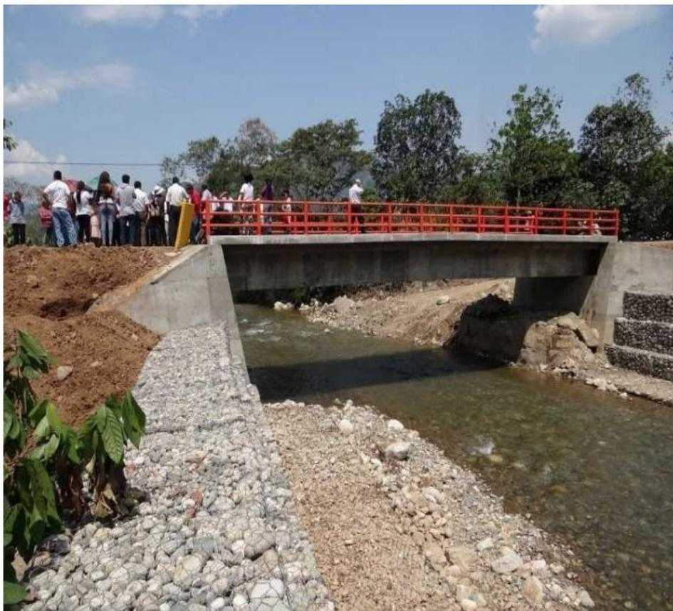
**Foto 03:** Gaviones instalados nuevo puente Paratushali-Satipo
