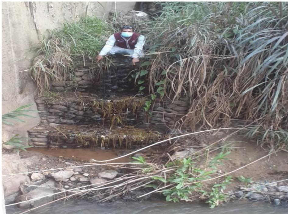
**Foto 06:** Gaviones del estribo derecho del puente Timarini 1
