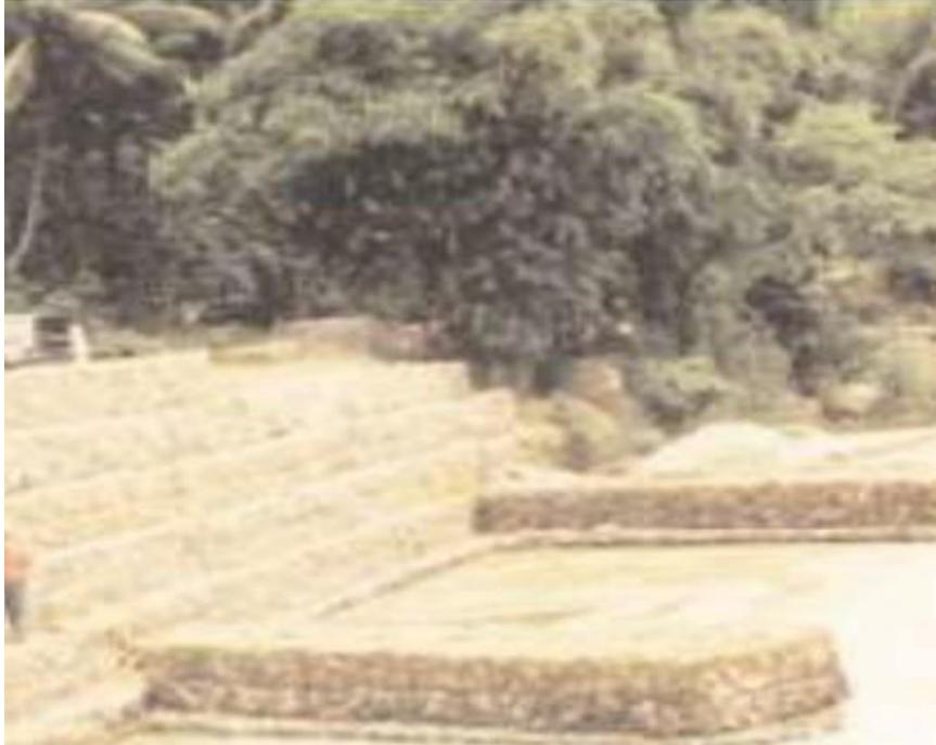
*Figura N° 03. Obra deflectora (Espigón) en gaviones.*
