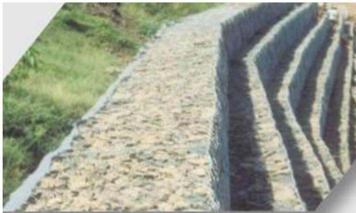
*Figura N° 01. Estructura gruesa en gaviones.*
