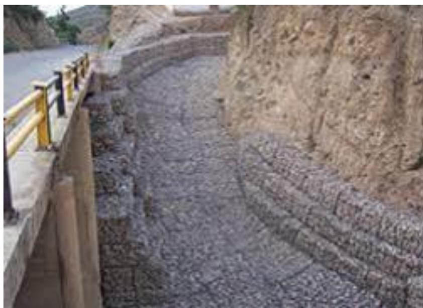
**Foto 04:** Gaviones para protección de estribos TDM-Perú (2020).
