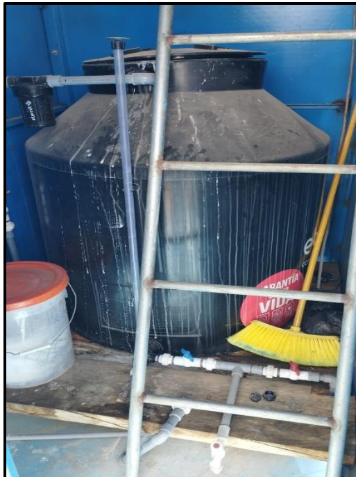
Figura 14: Sistema de cloración
