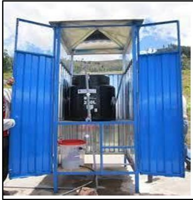
Figura 10: Caseta de cloración por goteo
