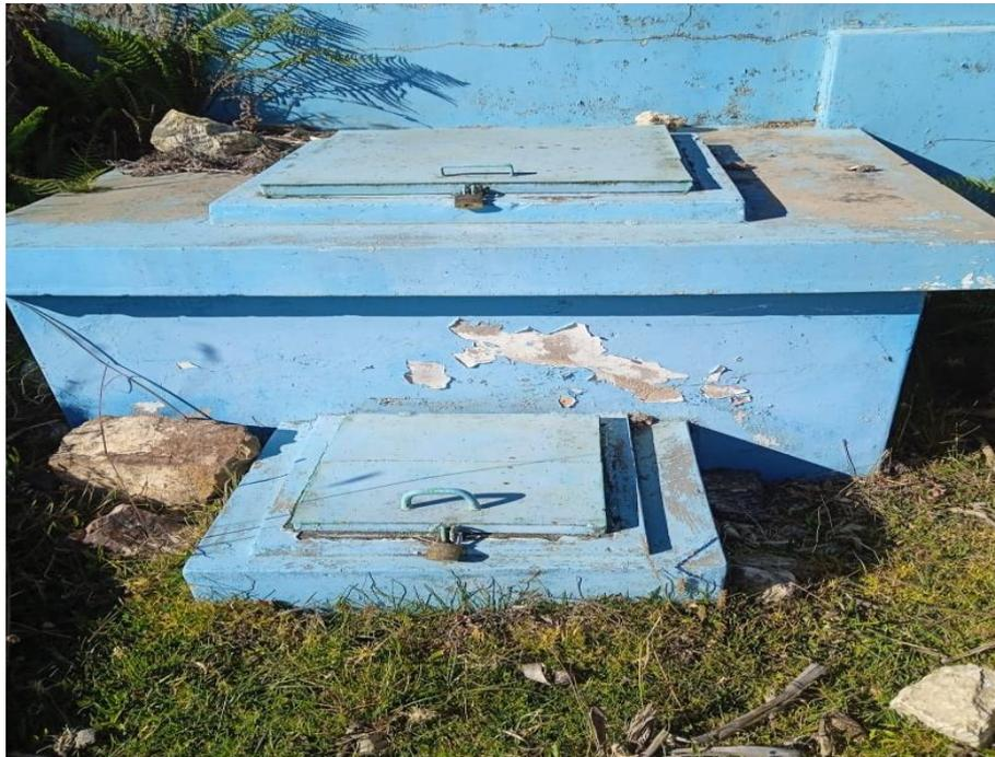
Figura 10: Cámara de captación del sistema de abastecimiento de agua potable del caserío de Yuracmarca.
