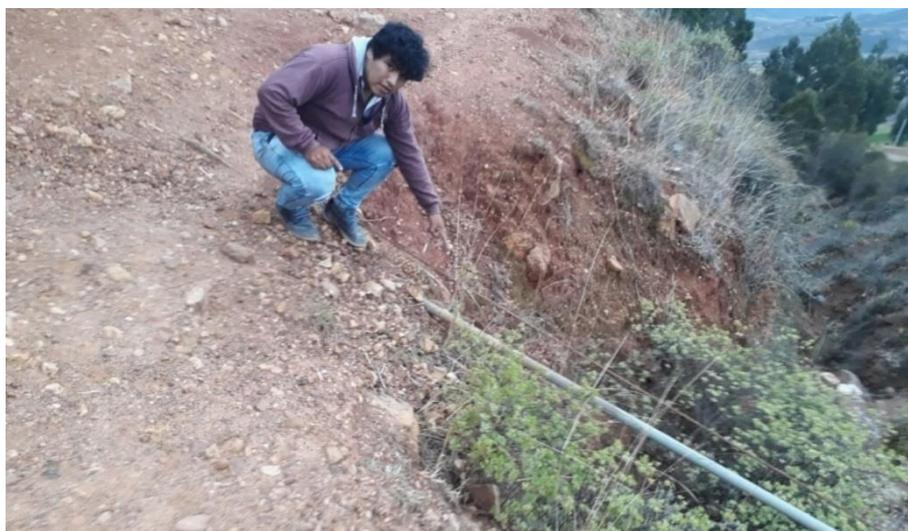
Figura 12: Línea de aducción del sistema de abastecimiento de agua potable del caserío de Yuracmarca.
