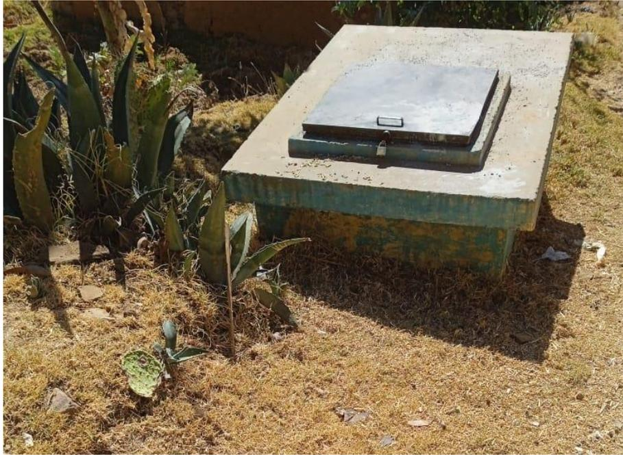
Figura 13: Cámara rompe presión en la línea de conducción del sistema de abastecimiento de agua potable del caserío de Yuracmarca.
