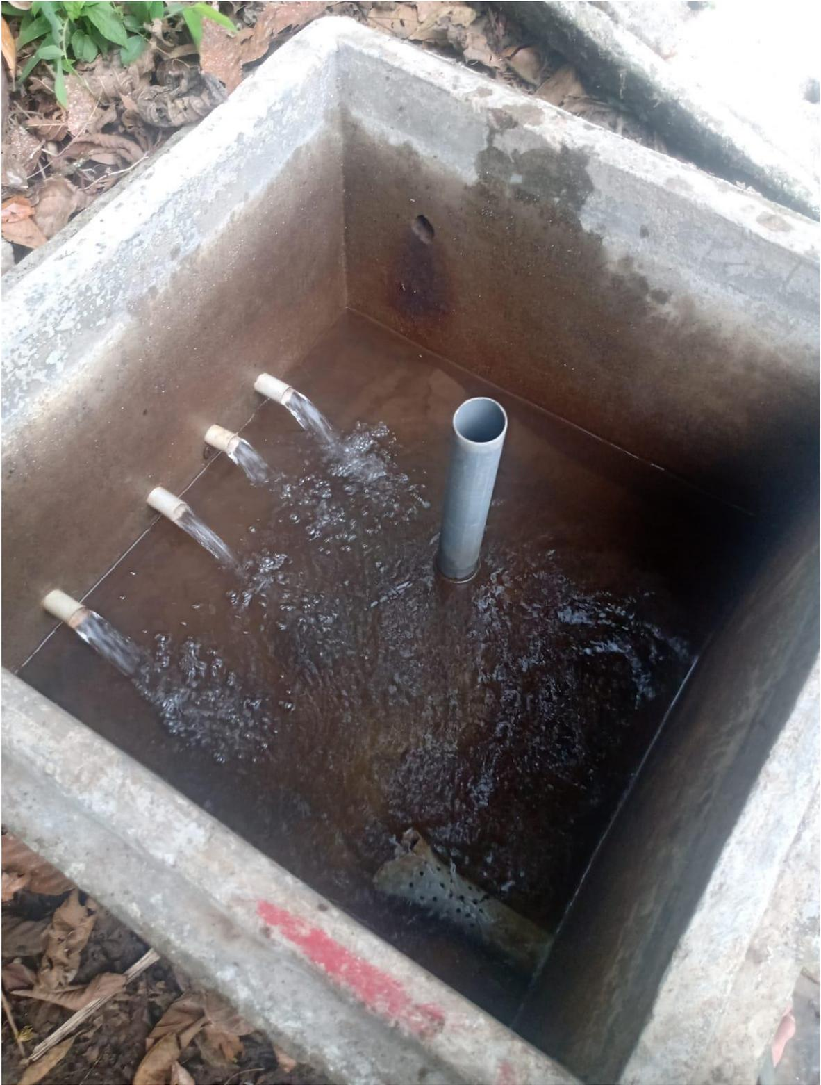
Figura 9: Entrada de agua por medio de 4 tubos de  $\frac{3}{4}$  de pulgada
