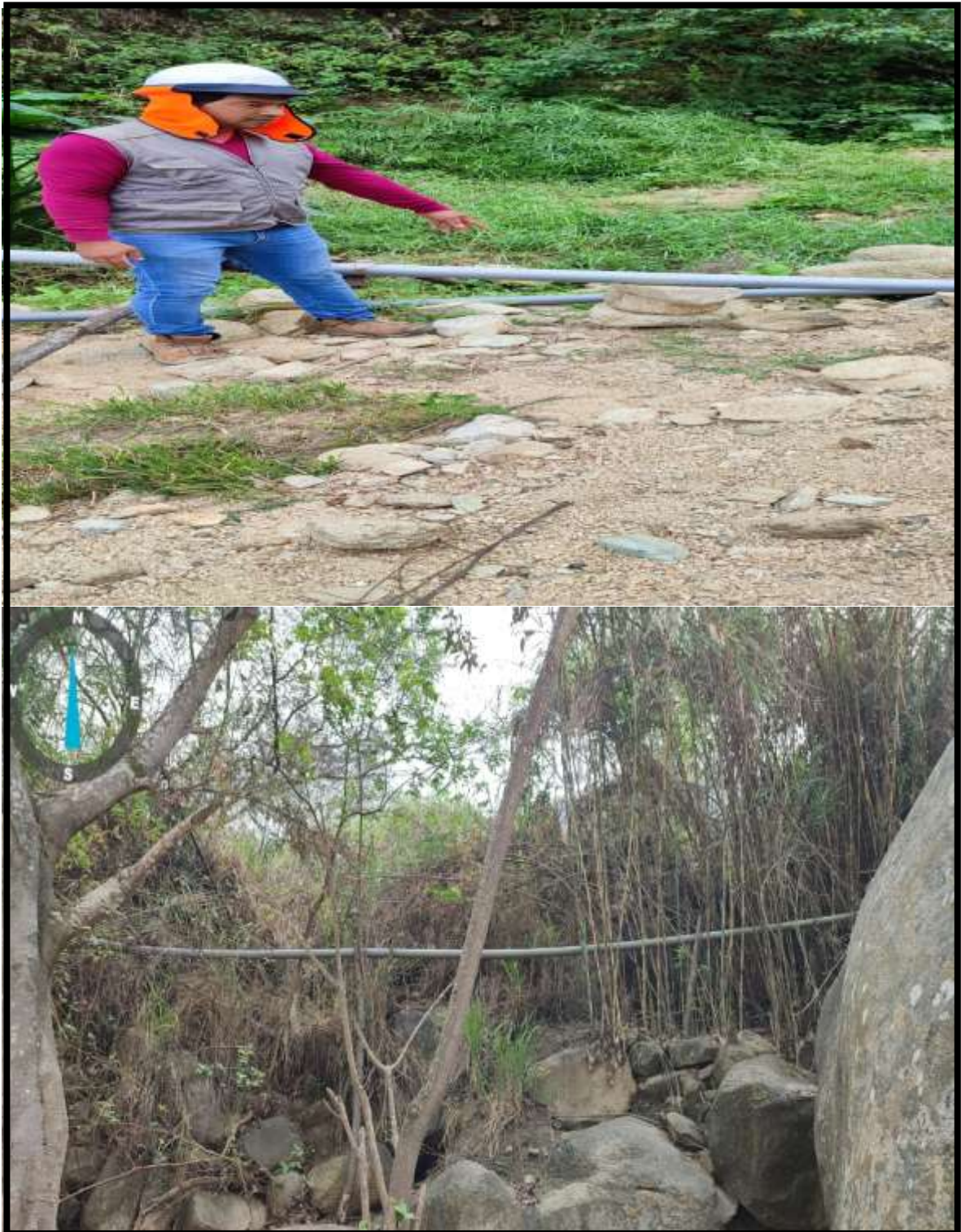
Imagen 4: Línea de aducción
