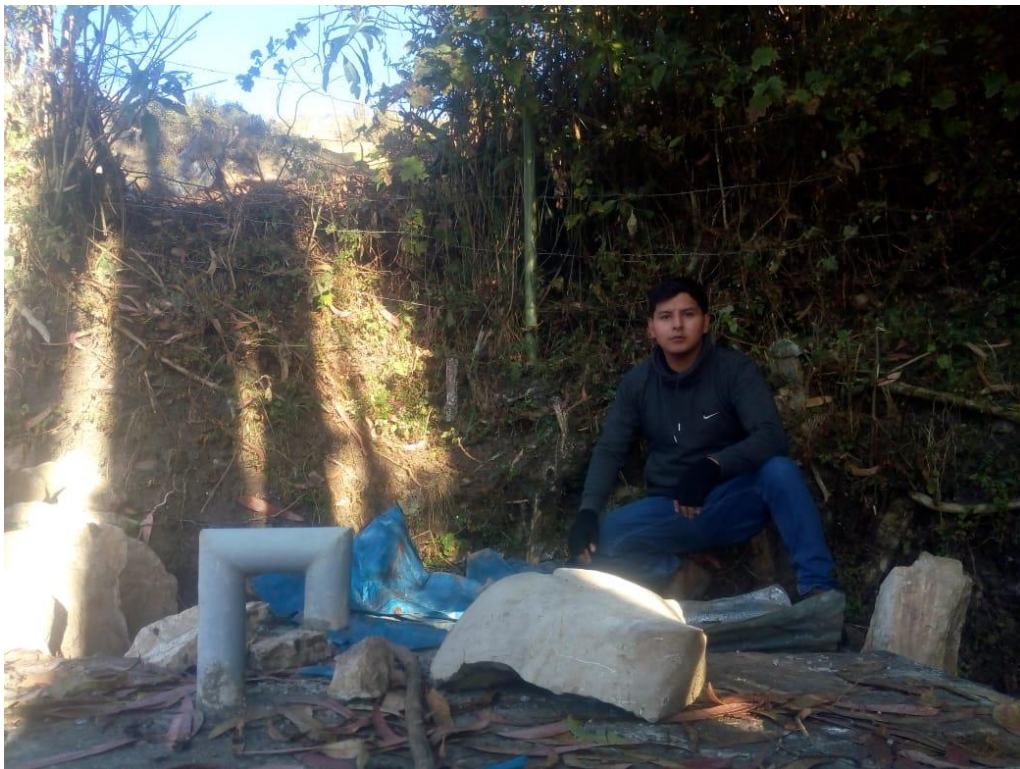
Figura 39. Verificación de la cámara de captación
