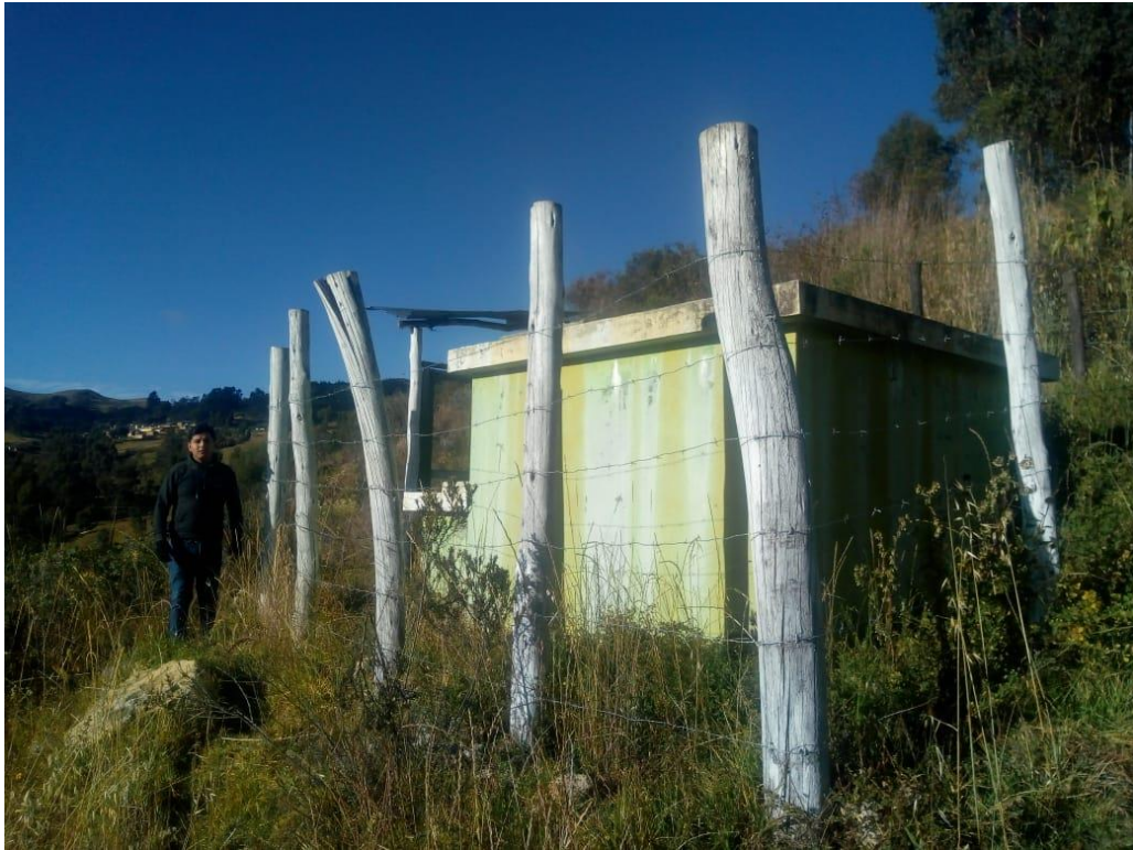
Figura 38. Se muestra el reservorio de almacenamiento
