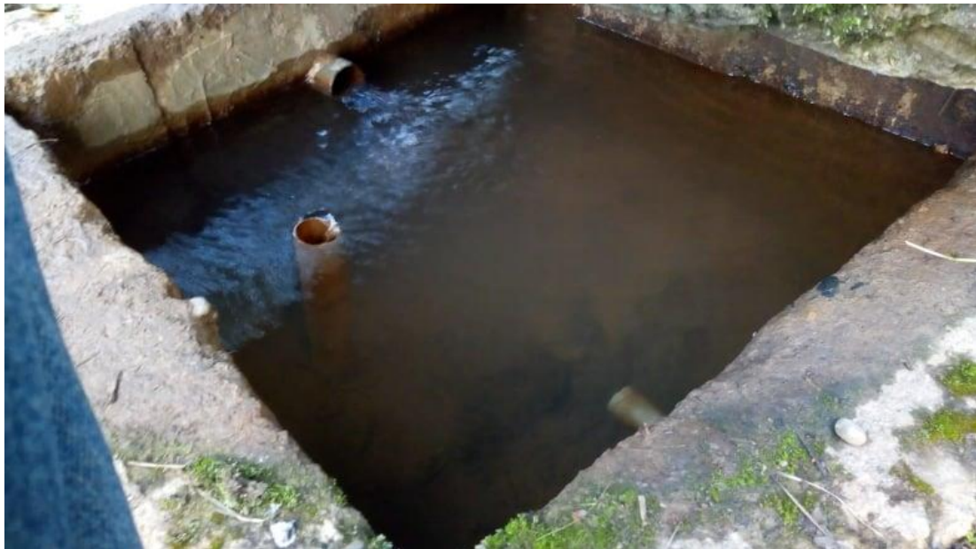
Fotografía 6 Cámara húmeda del reservorio
