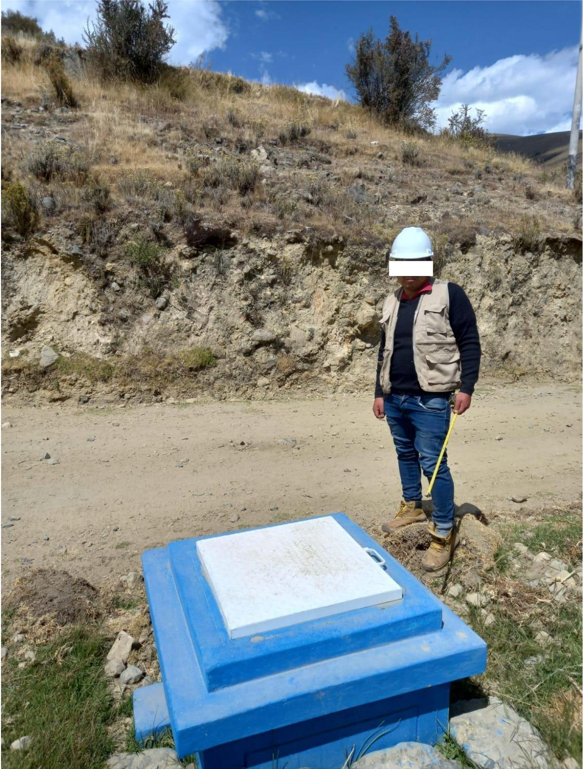
Figura 15: Cámara rompe presión – línea de conducción
