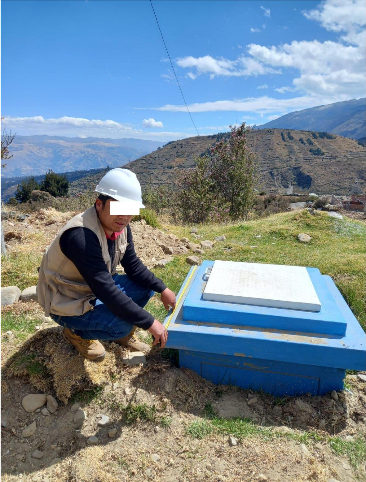
Figura 19: Cámara rompe presión – línea de aducción
