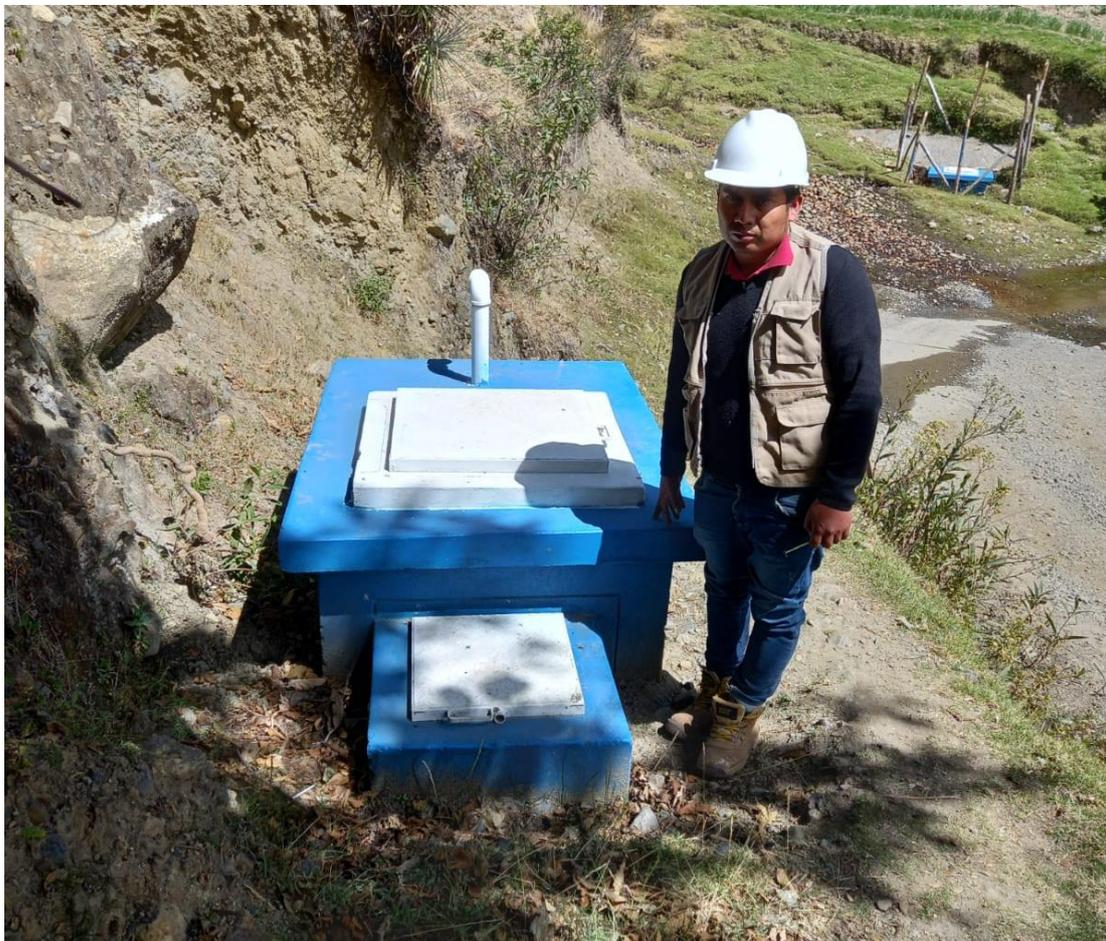
Imagen 4: Fotografía de evidencia de la cámara rompe presión tipo 7
