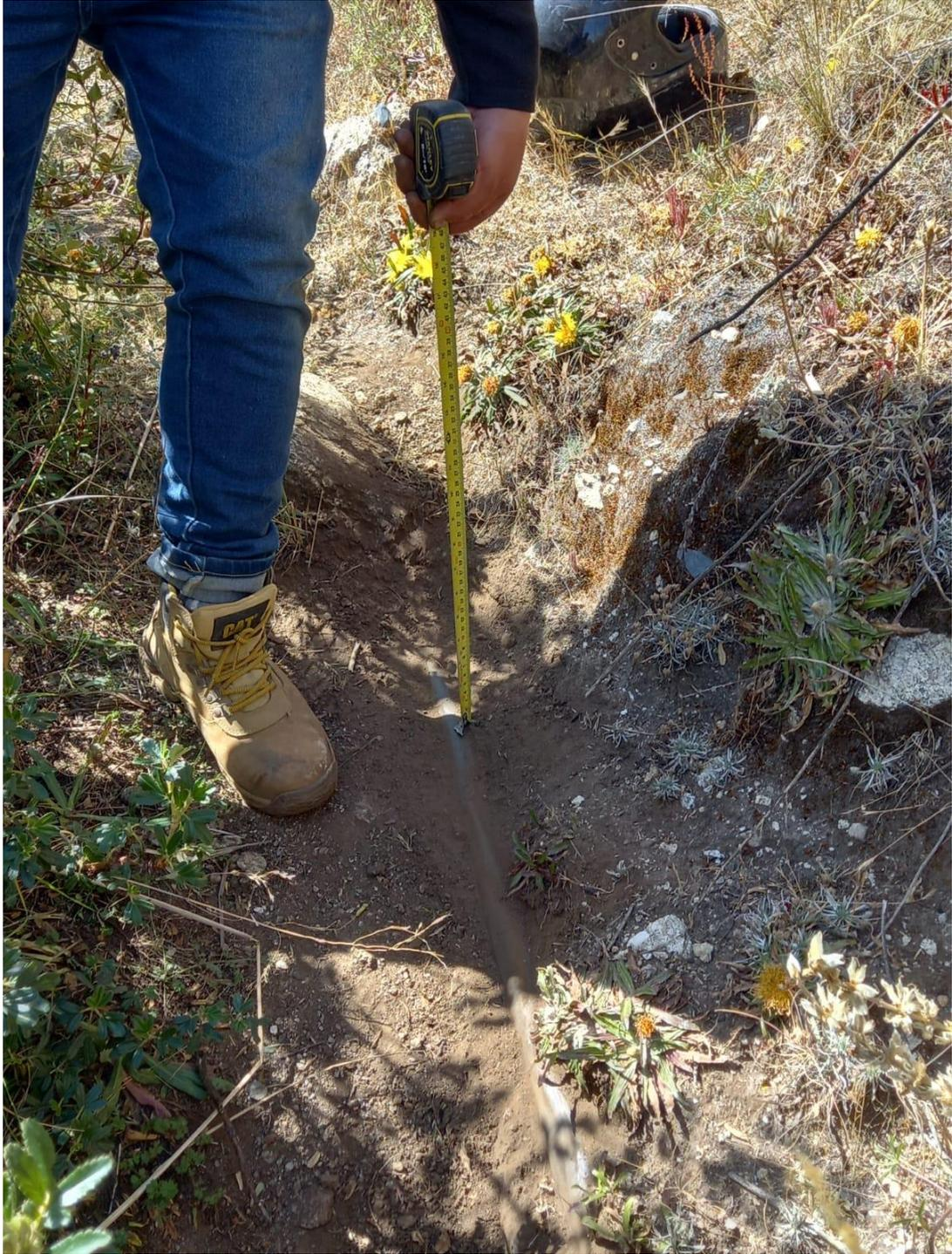
Figura 14: Tubería expuesta en línea de conducción
