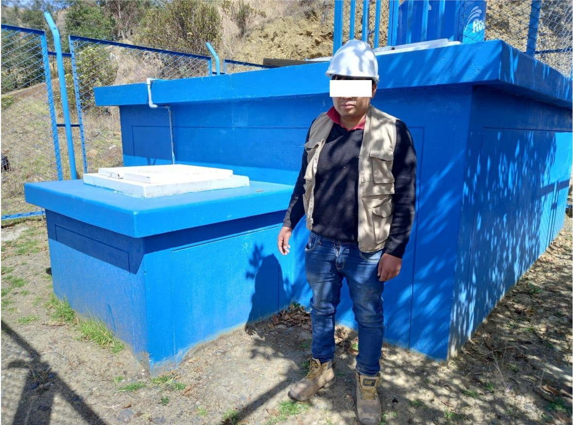
Figura 18: Reservorio y cisterna de cloración
