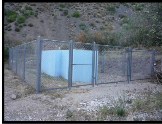
Figura 6: Cerco perimétrico Fuente: Sistema de protección
