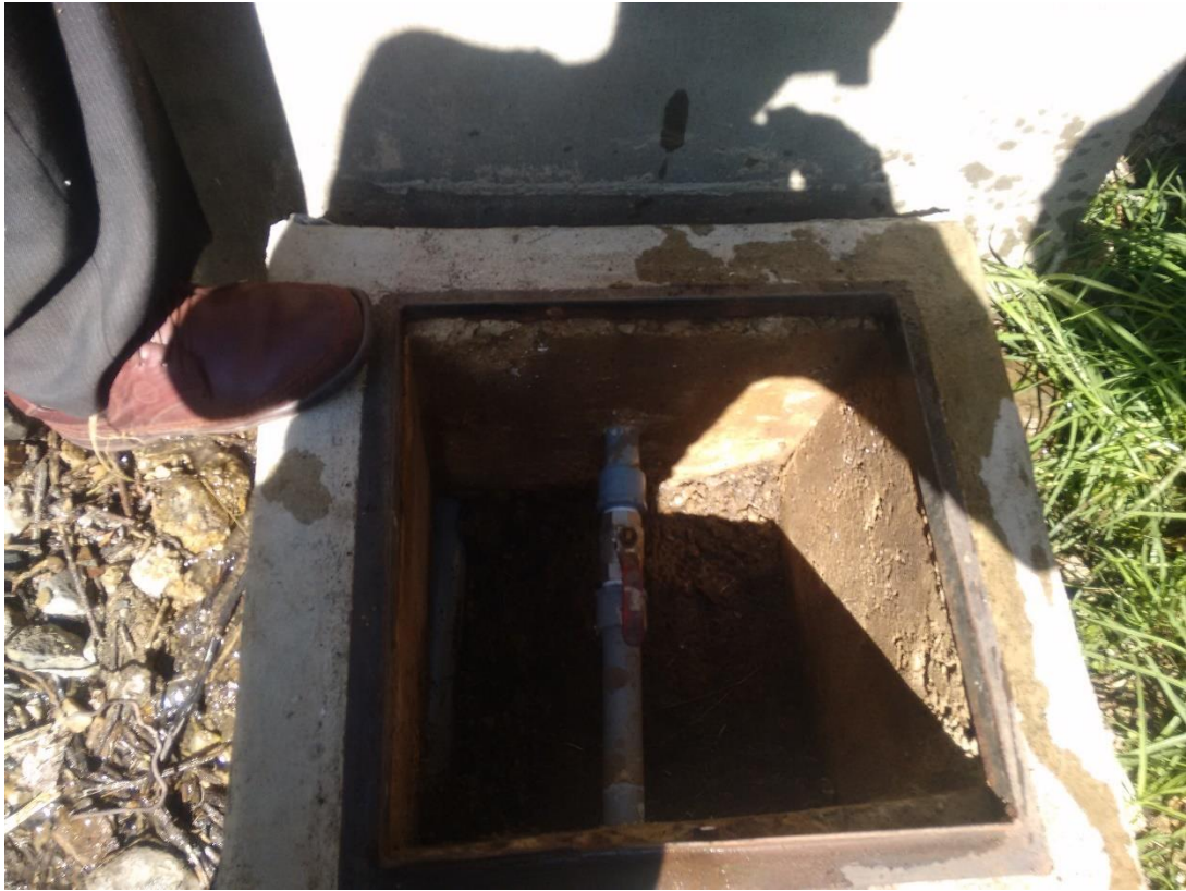
Figura 13: Interior de la cámara seca
