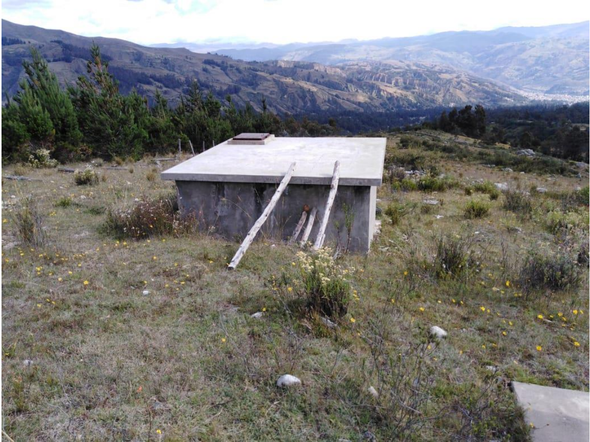
Figura 15: Reservorio actual de la Localidad de Nueva Victoria
