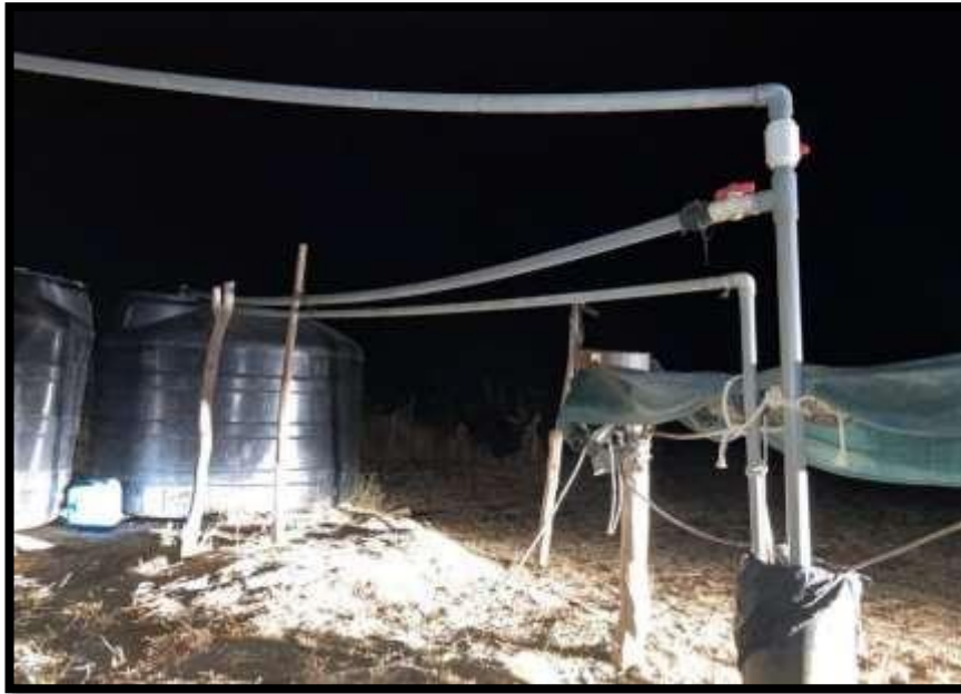
FOTO N°01- TUBERIA INSTALADA A LOS TANQUES DE AGUA
