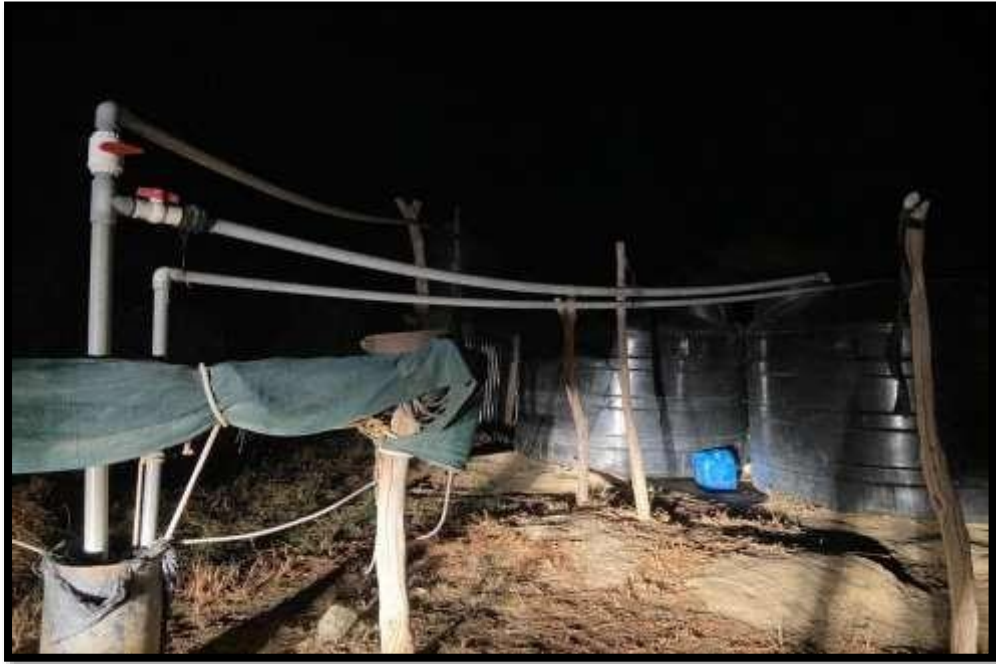
FOTO N°03- TUBERIA INSTALADA A LOS TANQUES DE AGUA
