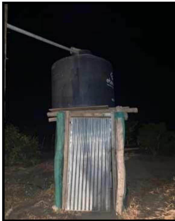
FOTO N°02 – TANQUE DE AGUA INSTALADA
