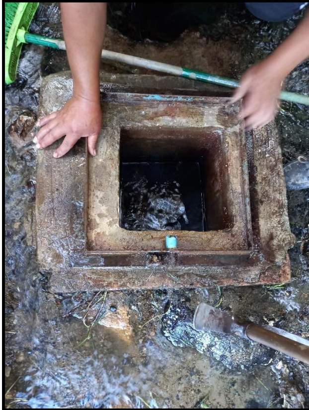
Figura 37: Interior de la captación.
