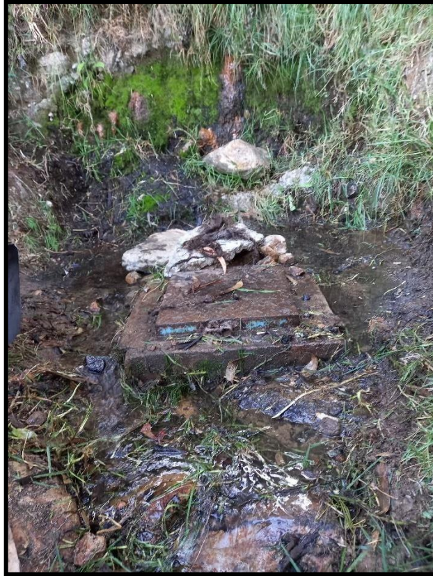
Figura 36: Captación cubierta de malezas.
