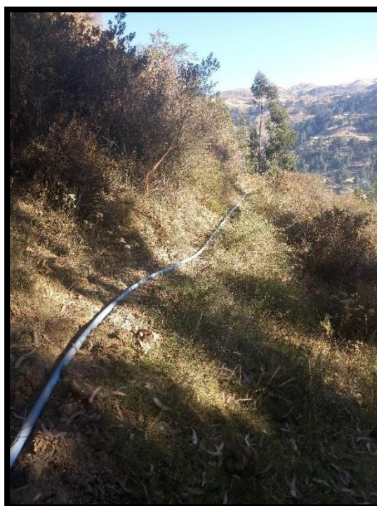
Figura 11: Línea de conducción expuesta en uno de los tramos.
