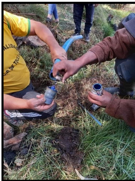
Figura 24: Reparación de línea de C.
