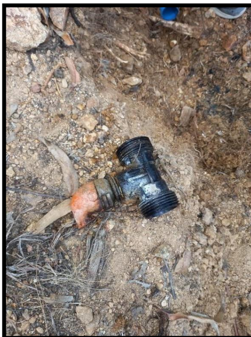
Figura 22: Válvula de aire.
