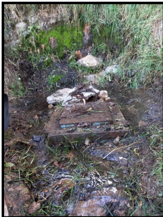
Figura 16: Captación llena de arbustos.
