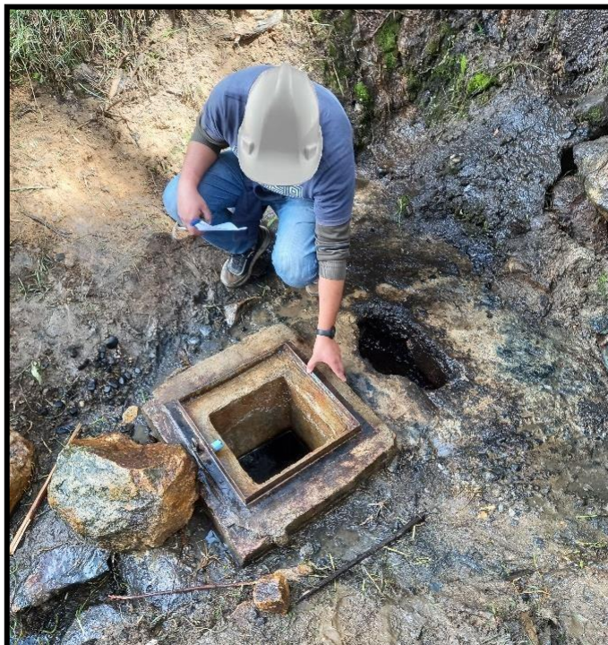
Figura 32: Medición del área de la captación.
