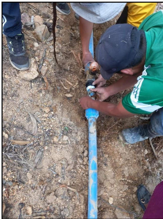
Figura 35: Verificación de funcionamiento de la válvula de aire.
