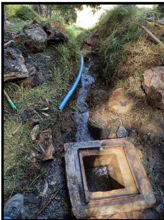
Figura 10: Línea de conducción desde la captación.
