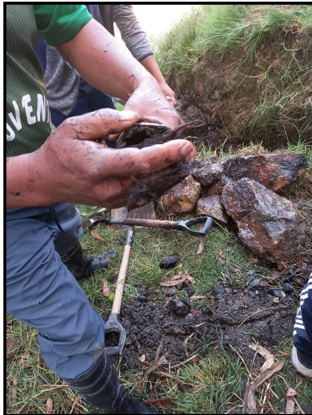
Figura 45: Limpieza de la tubería de entrada.
