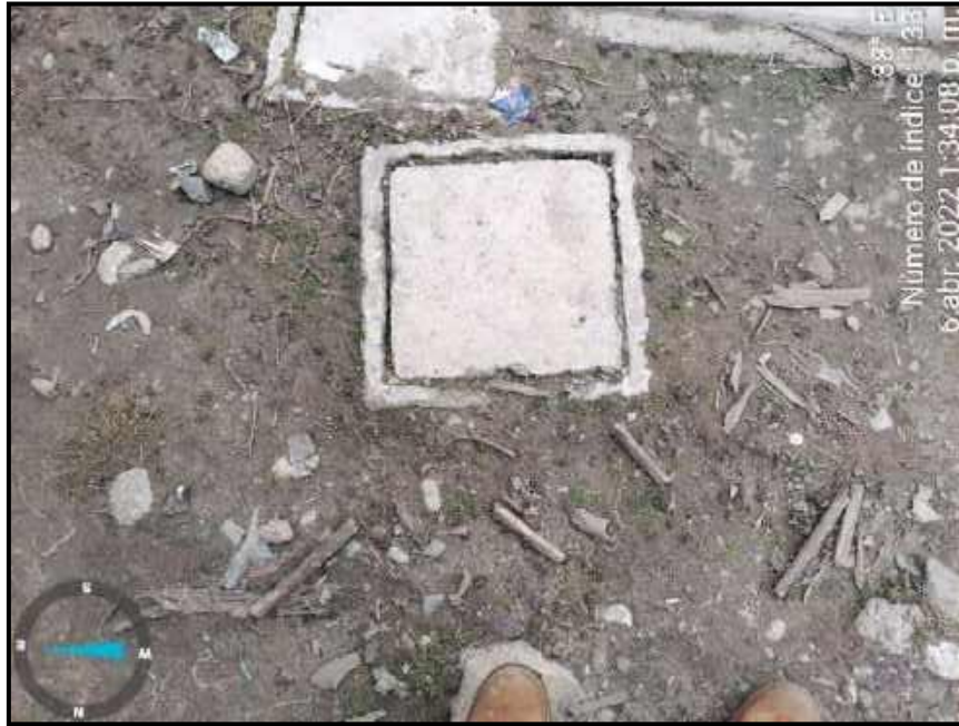
Figura 15: Caja de registro de conexiones domiciliarias
