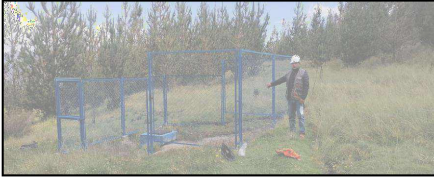
Figura 11: Cerco perimétrico de la captación
