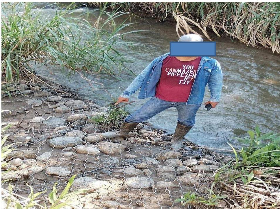
**Figura 13. Estado deteriorado en el gavion tipo colchon tramo 0+000 a 0+010.**
