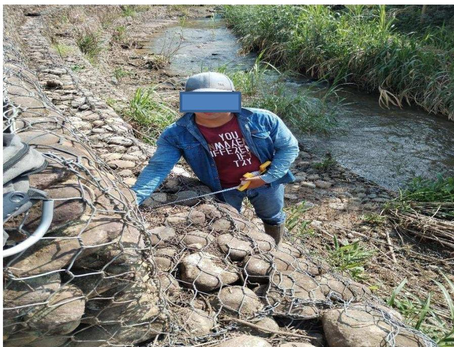
**Figura 18. Medicion del 4 nivel del gavion.**
