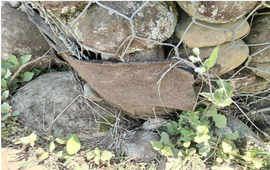
**Figura 20. El gavion tipo caja cuenta con geotextil.**
