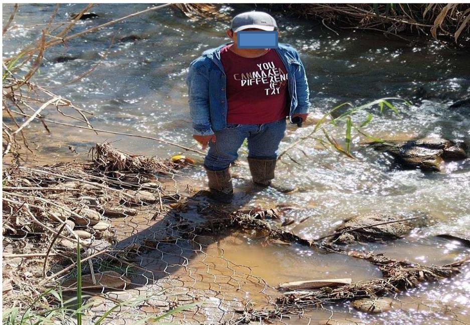
**Figura 15. Estado deteriorado en el gavion tipo colchon tramo 0+020 a 0+030.**
