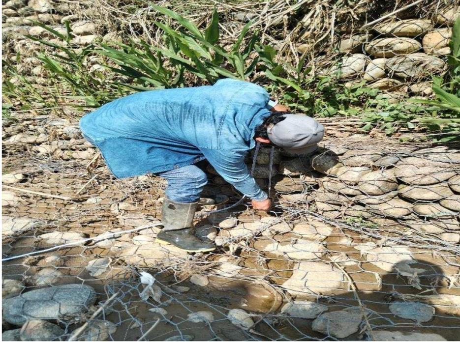
**Figura 11. Medición de la altura del primer nivel del gavion tipo caja.**
