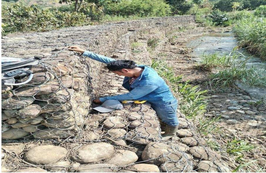
**Figura 19. Medición ultimo nivel de gavion tipo caja**
