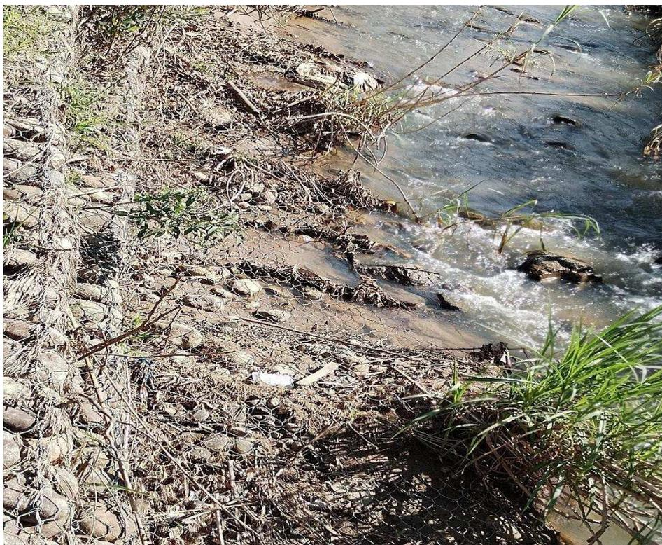
**Figura 14. Estado deteriorado en el gavion tipo colchon tramo 0+010 a 0+020.**
