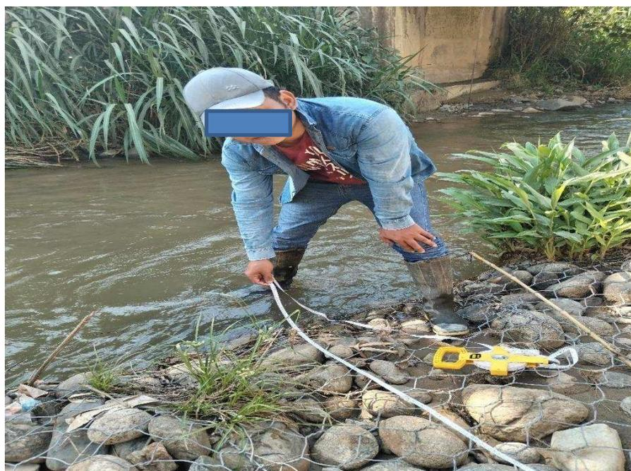
**Figura 8. Medicion de la longitud del colchon de gavion, 2.30m**
