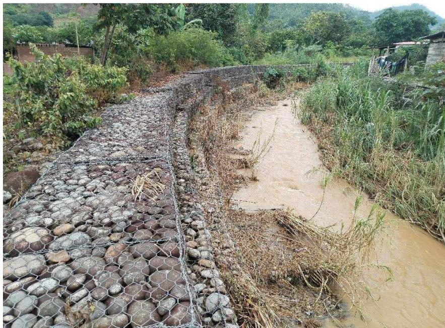
**Figura 7. Vista del ultimo nivel del gavion**
