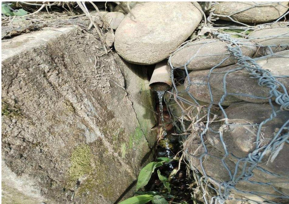
**Figura 12. Tubería de drenaje de 2"**
