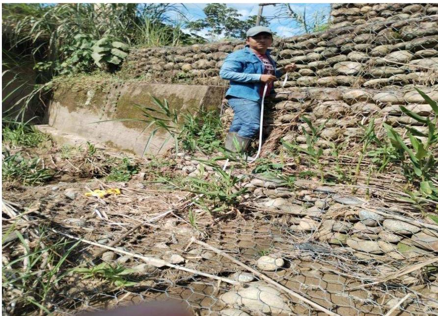
**Figura 17. Presencia de maleza en el 2 nivel del gavion, además hay un muro de constención.**
