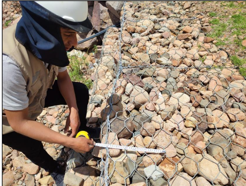
Figura 14: Se visualiza realizando las medidas de las cocadas de la malla. Fuente: Ilustración propia
