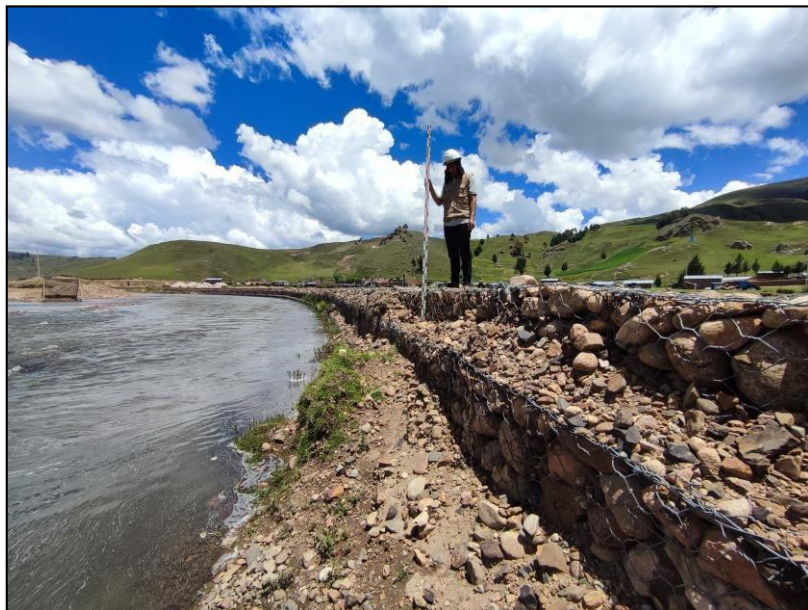
Figura 23: Se visualiza la progresiva 0+140 del muro del muro de gaviones Fuente: Ilustración propia
