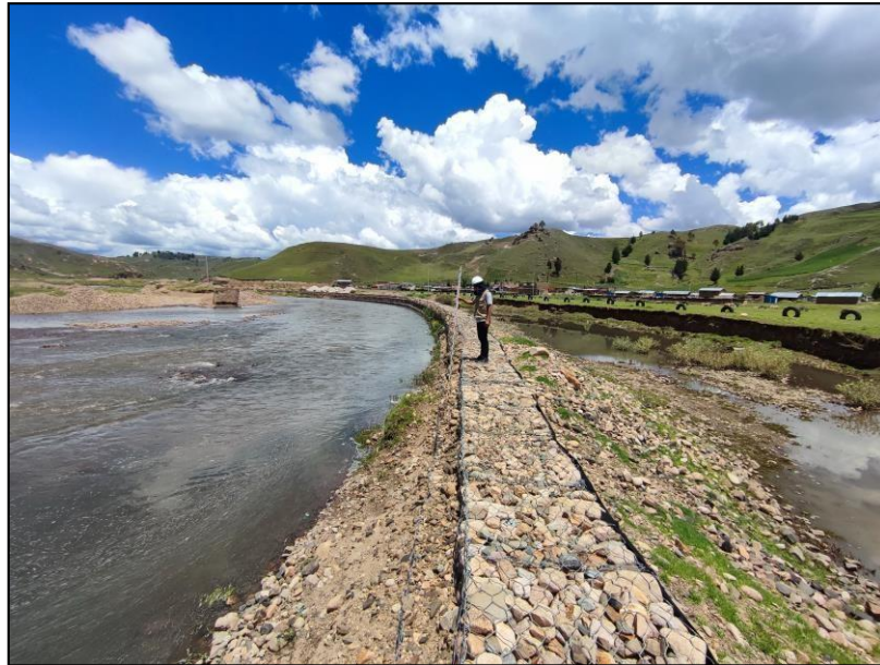
Figura 24: Se visualiza la progresiva 0+160 del muro del muro de gaviones Fuente: Ilustración propia
