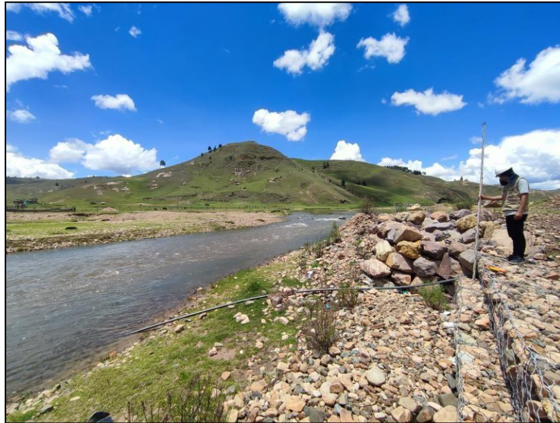
Figura 16: Se visualiza la progresiva 0+00 del muro del muro de gaviones Fuente: Ilustración propia
