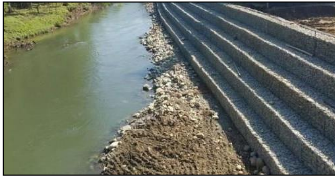
Figura 6: Se puede visualizar un muro de contención tipo gaviones
