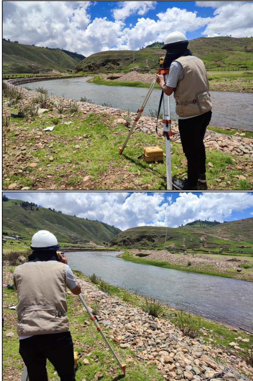
Figura 13: Se visualiza el control de nivel del muro de gavión.
