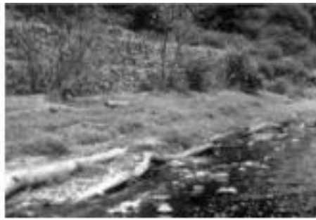
Fig. 9.13 Bolivia: protección con troncos de la plataforma anti-erosión en colchones Reno®
