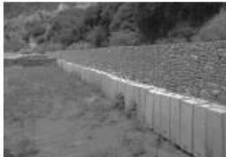
Fig. 9.17 Bolivia: protección de gaviones caja con elementos prefabricados de concreto
