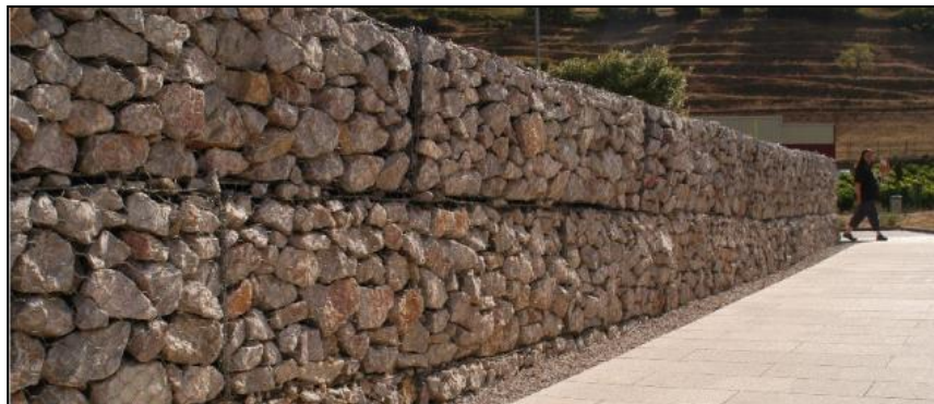
Figura 5: Se visualiza los fragmentos de piedras en un muro de gavión.
