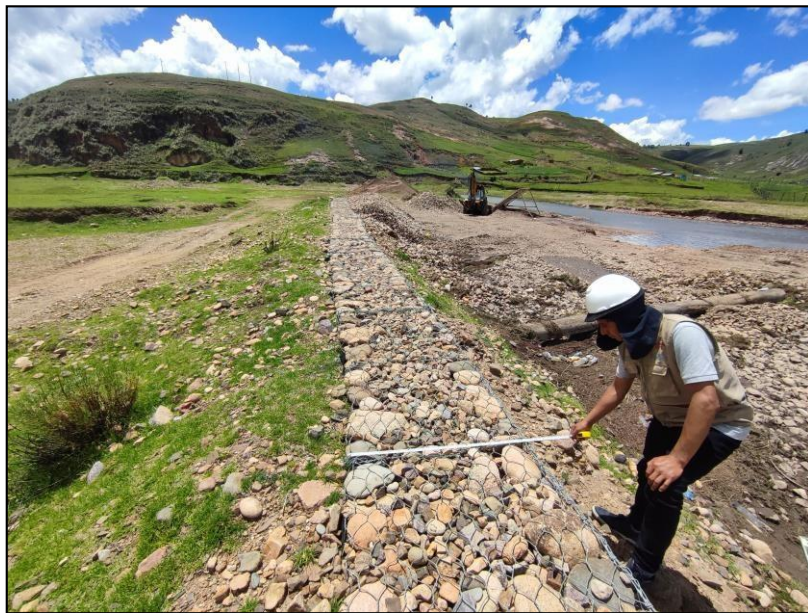
Figura 25: Se visualiza la progresiva 0+180 del muro del muro de gaviones Fuente: Ilustración propia
