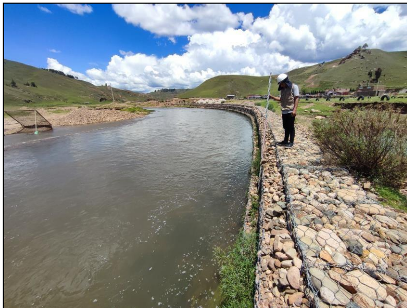
Figura 21: Se visualiza la progresiva 0+100 del muro del muro de gaviones Fuente: Ilustración propia
