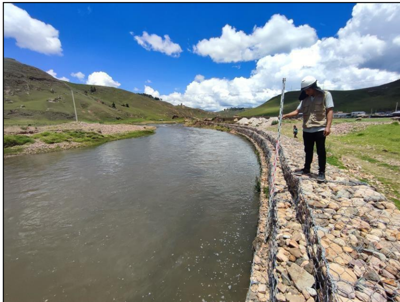
Figura 19: Se visualiza la progresiva 0+060 del muro del muro de gaviones Fuente: Ilustración propia
