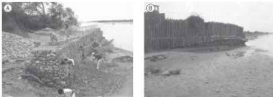
Fig. 9.12 Espigones en gaviones caja protegidos contra la abrasión con troncos
