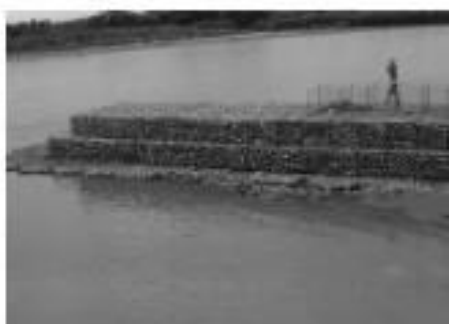
Fig. 9.20 Obra construida con gaviones CajaFuerte ®
