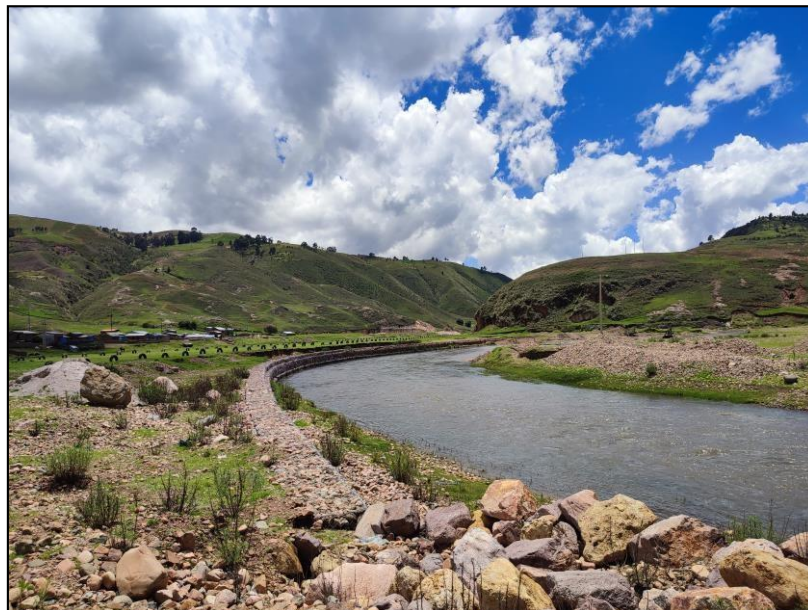
Figura 12: Fotografía panorámico del muro de gaviones. Fuente: Ilustración propia
