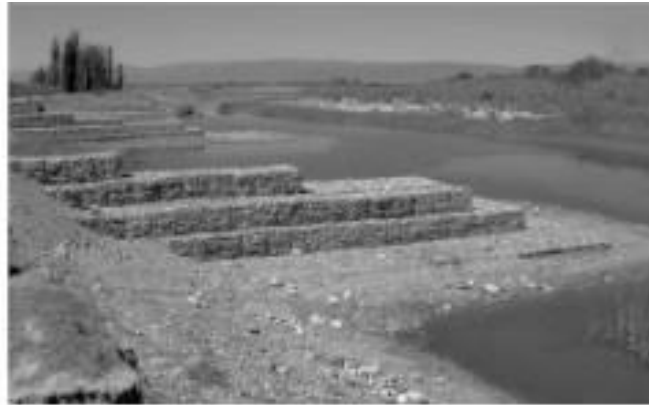
Fig. 9.5 Espigón en gaviones apoyado sobre una camada de piedras sueltas
