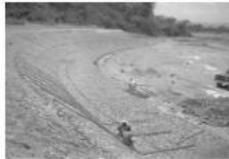
Fig. 9.16 Venezuela: protección de revestimiento de colchones Reno® con concreto vaciado en construcción
