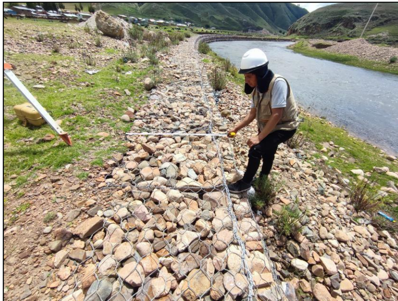
Figura 29: Se ilustra recolectando datos como medidas de muro tipo caja.
