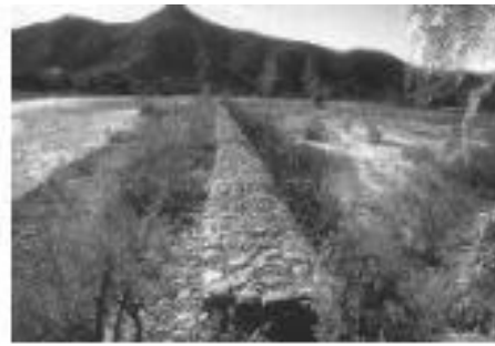
Fig. 9.14 Protección contra la abrasión de espigones de gaviones caja con vegetación
