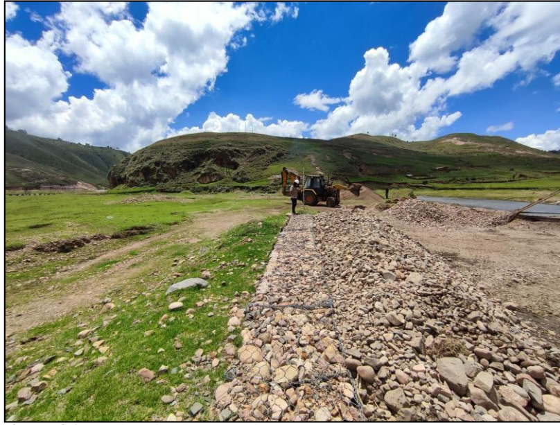
Figura 26: Se visualiza la progresiva 0+204 del muro del muro de gaviones Fuente: Ilustración propia
