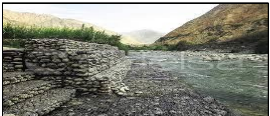
Figura 1: Muro de gavión
