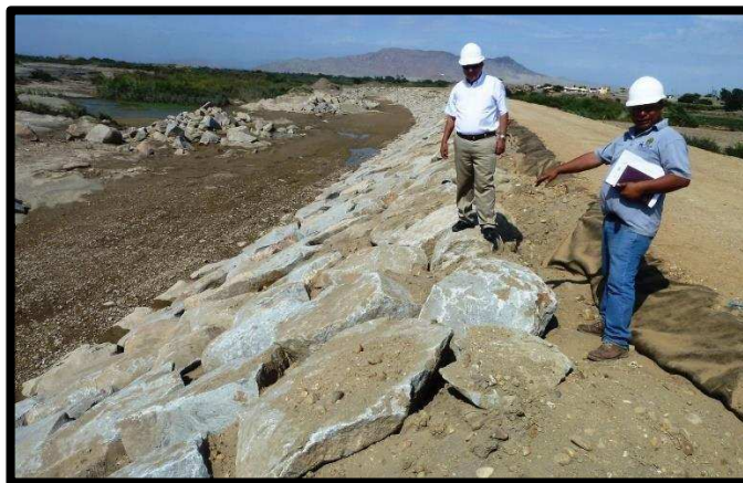
Figura 7: Mejoramiento de la defensa ribereña
