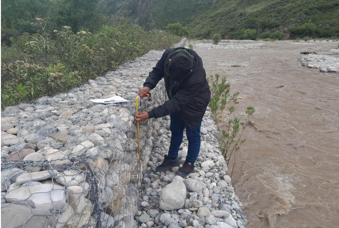
Foto 05: Se observa la medición de la altura de la estructura existente.
