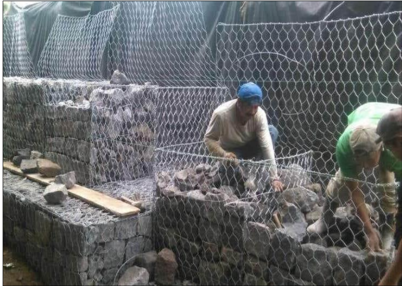
Figura 06: Mano de obra no especializada para el armado de gaviones
