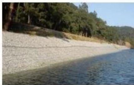
Figura 2. Gaviones para contención fluvial. Fuente: (A Bianchini, 2017).
