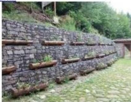
Figura 1. Estructura con gaviones. Fuente: http://www.solucionesespeciales.net/MedioAmbiente/Gaviones/Gaviones.aspx
