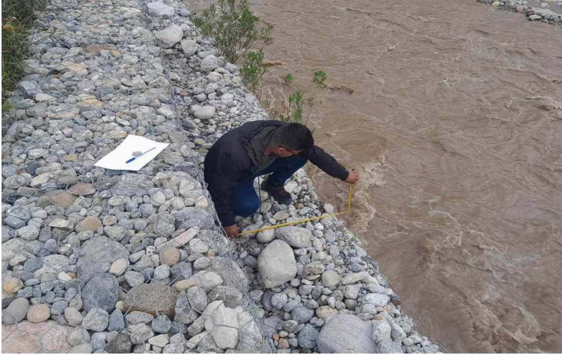
Foto 03: Se observa la medición del ancho de la cama de la estructura.
