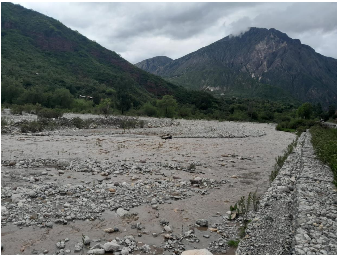
Foto 12: Se observa el fuerte caudal que provoca las lluvias en épocas de estiaje.
