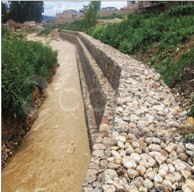
Figura 05: Estética en los muros de gaviones.
