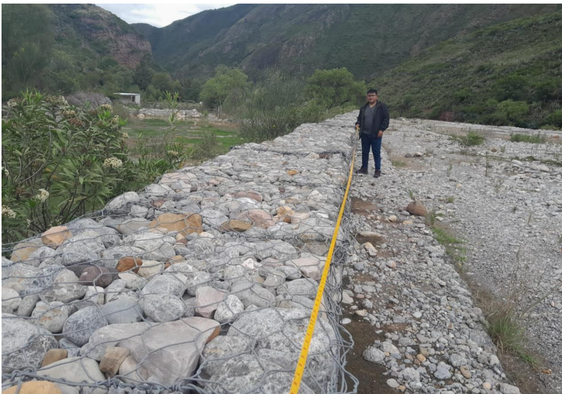
Foto 02: Se observa la medición de la longitud de la estructura existente.
