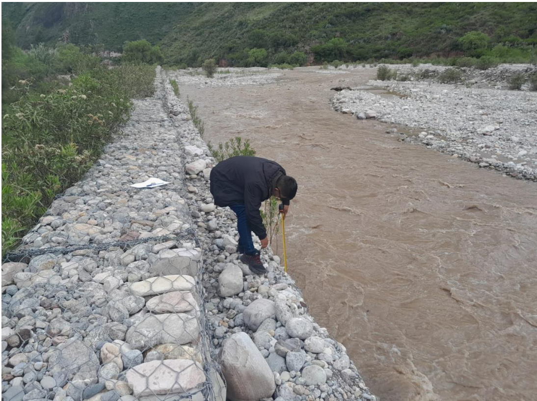
Foto 06: Se observa la medición de la altura libre con respecto al nivel del agua.
