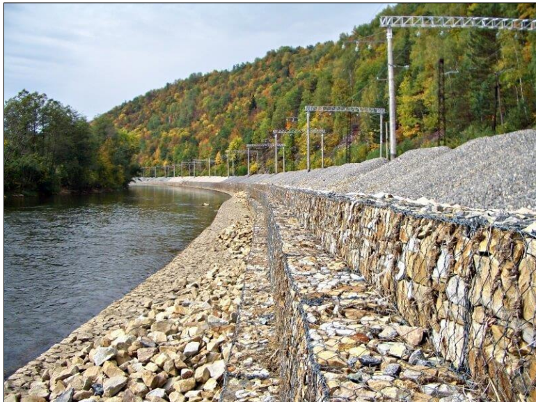
Figura 08: Versatilidad de muros de gaviones. Fuente: trumers chutzbauten-2024.
