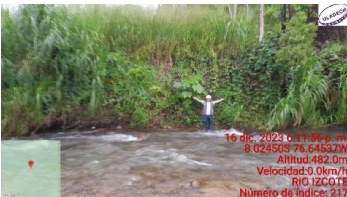
Fotografía 18: Margen izquierdo de la defensa rivereña del rio izcote.
