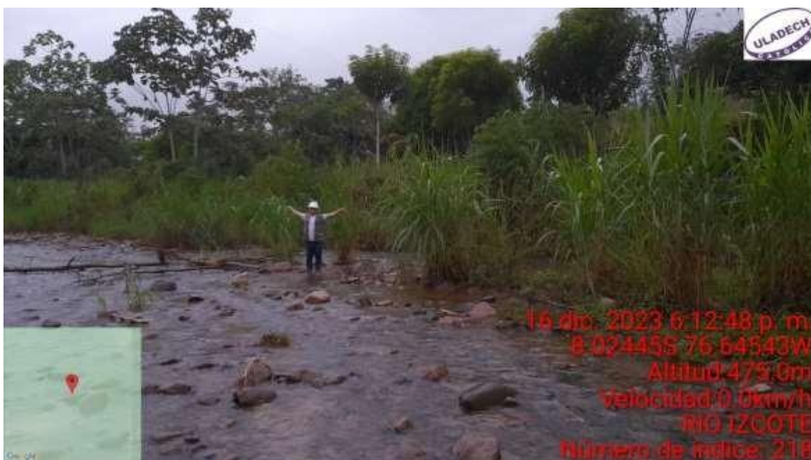
Fotografía 17: Margen derecho de la defensa rivereña del rio izcote.
