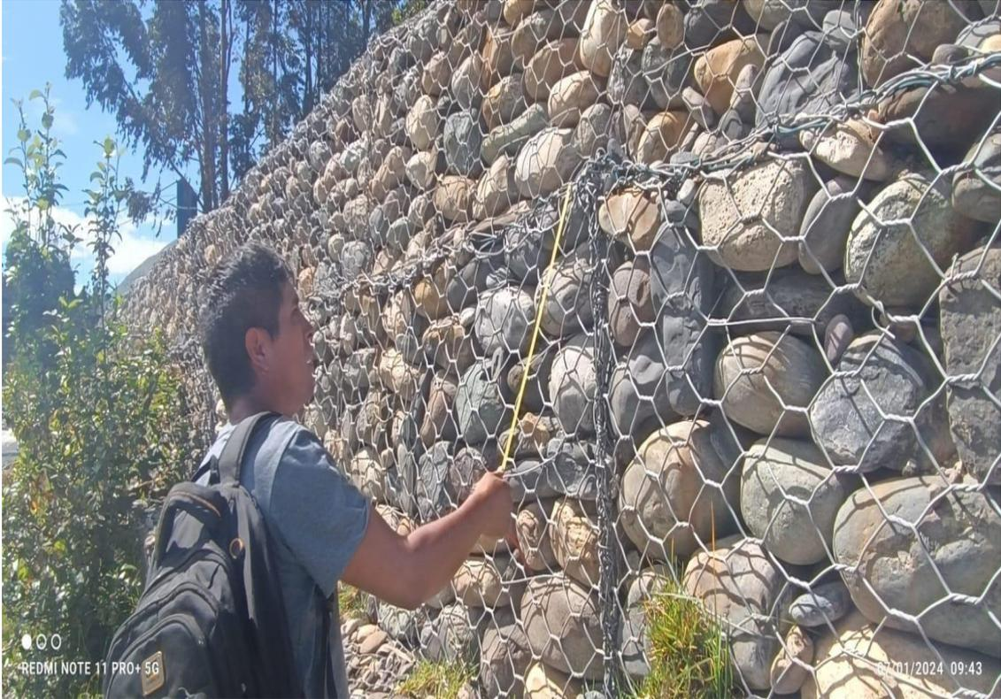
**FOTOGRAFIA 12:** En la imagen se observa que los tamaños de las rocas son pequeñas y sobrepasan fácilmente la abertura de la malla.
