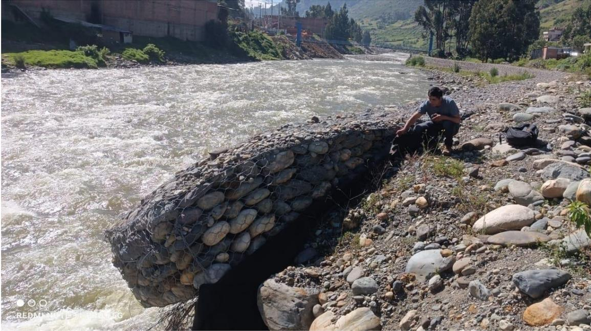
**FOTOGRAFIA 01:** Se observa la socavación y el empuje de la tierra, donde el muro de gavión ha fallado con una distancia de 6 metros.
