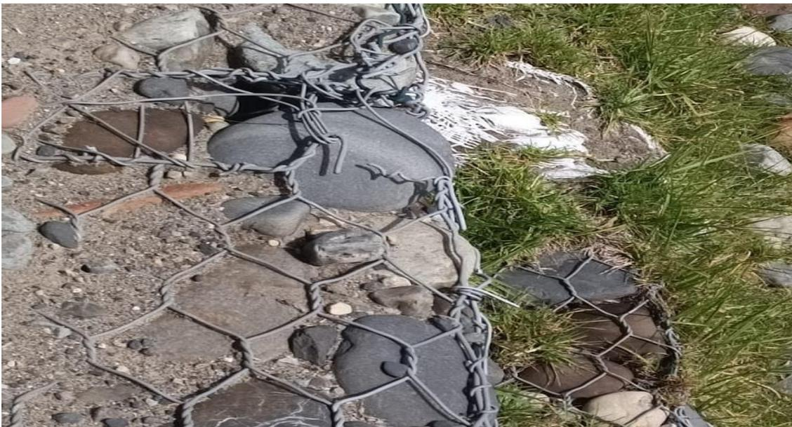
**FOTOGRAFIA 11:** En la imagen se observa la oxidación de la malla.
