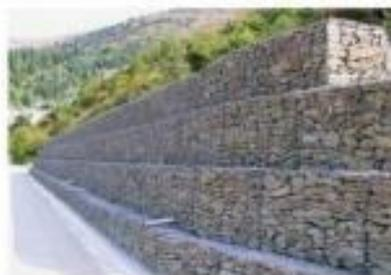
**Figura 2. Muro de contención flexible de gavión**
