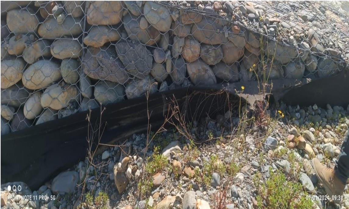
**FOTOGRAFIA 03:** En la imagen se observa que los tamaños de las rocas son pequeñas y sobrepasan fácilmente el diámetro de la malla.
