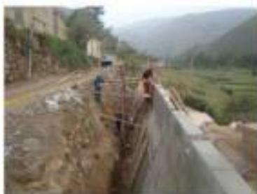
**Figura 1. Muro de contención rígido de concreto armado**
