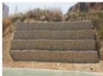
Figura 5. Muro de contención de gaviones
