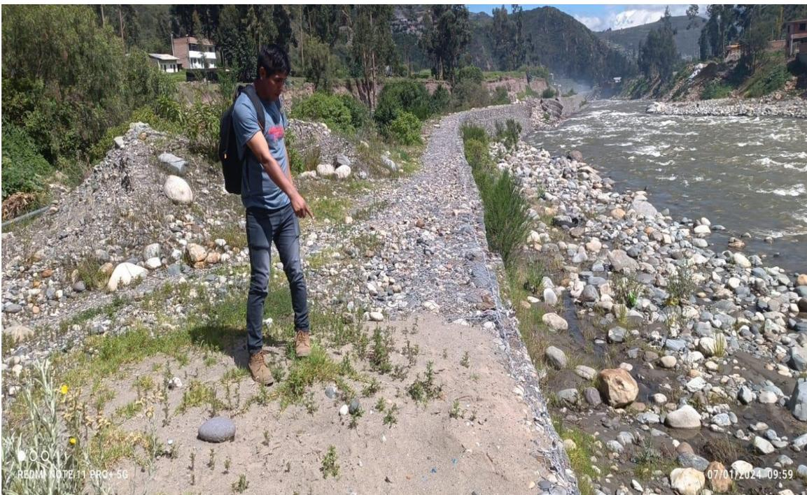
**FOTOGRAFIA 15:** En la imagen se observa el tramo del hundimiento del muro de gaviones.
