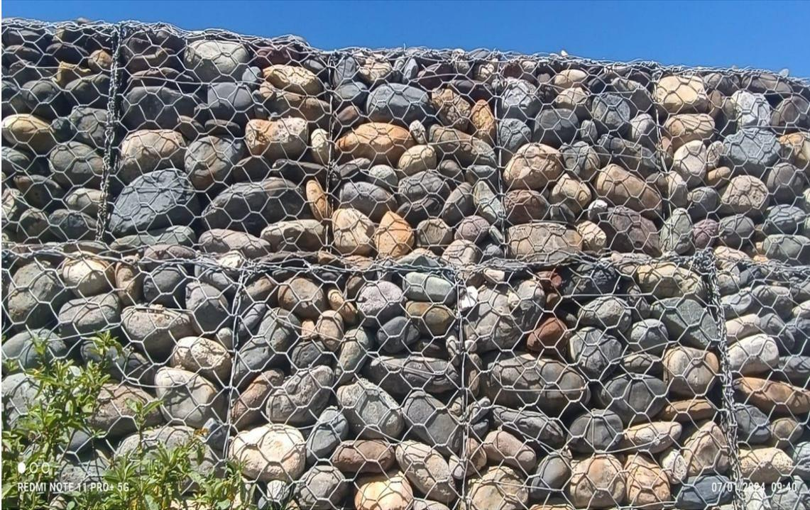
**FOTOGRAFIA 16:** En la imagen se observa la oxidación de la malla.
