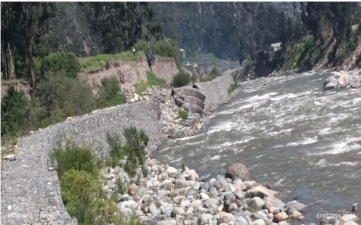
**FOTOGRAFIA 04:** En la imagen se observa el desplazamiento del gavión con una distancia de 6 metros.
