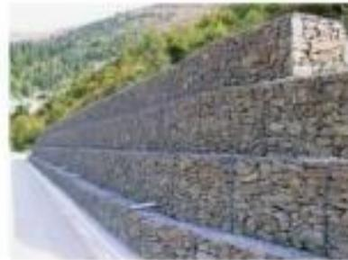
**Figura 2. Muro de contención flexible de gavión**
