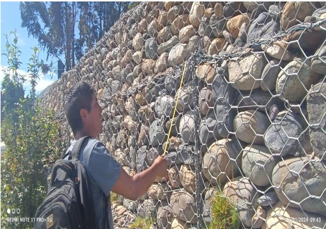
**FOTOGRAFIA 17:** En la imagen se observa que los tamaños de las rocas son pequeñas y sobrepasan fácilmente la abertura de la malla.
