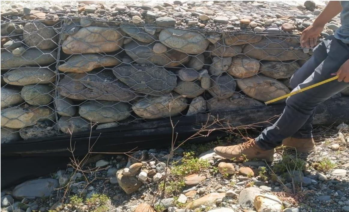
**FOTOGRAFIA 14:** En la imagen se observa que los tamaños de las rocas son pequeñas y sobrepasan fácilmente la abertura de la malla.
