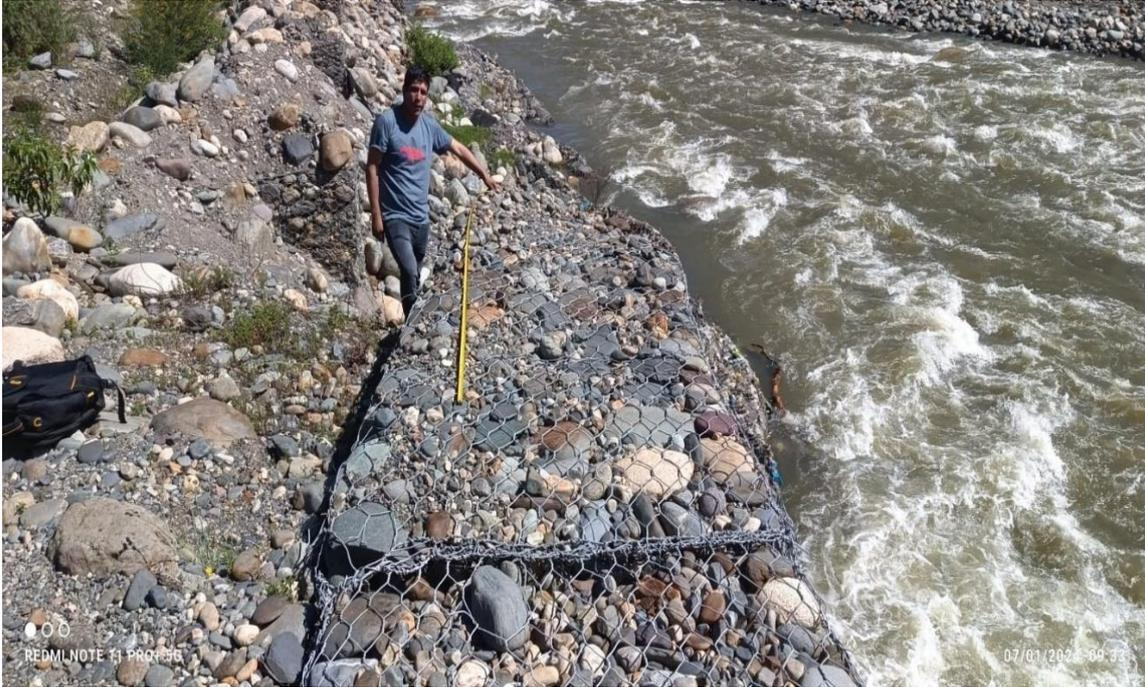
**FOTOGRAFIA 05:** En la imagen se observa la oxidación de la malla.
