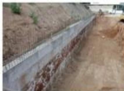
Figura 3. Muro de contención de concreto reforzado
