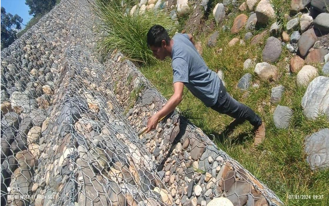
**FOTOGRAFIA 07:** En la imagen se observa el rompimiento de la malla.
