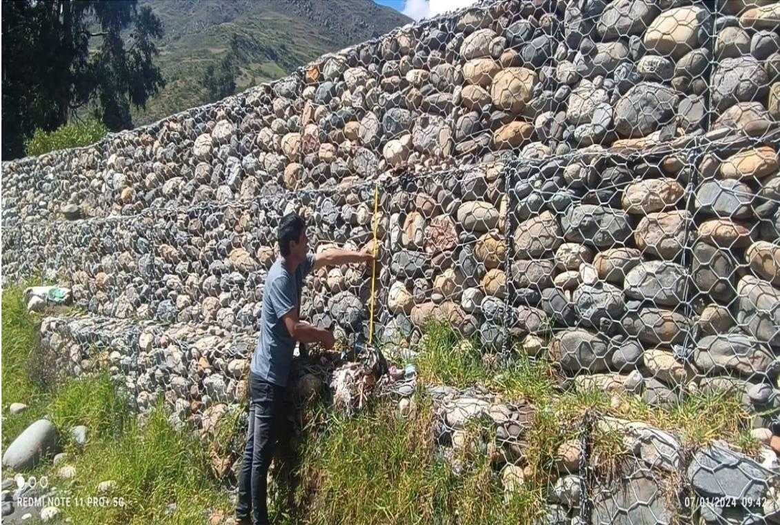
**FOTOGRAFIA 10:** En la imagen se observa que los tamaños de las rocas son pequeñas y sobrepasan fácilmente la abertura de la malla.
