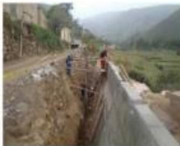
**Figura 1. Muro de contención rígido de concreto armado**
