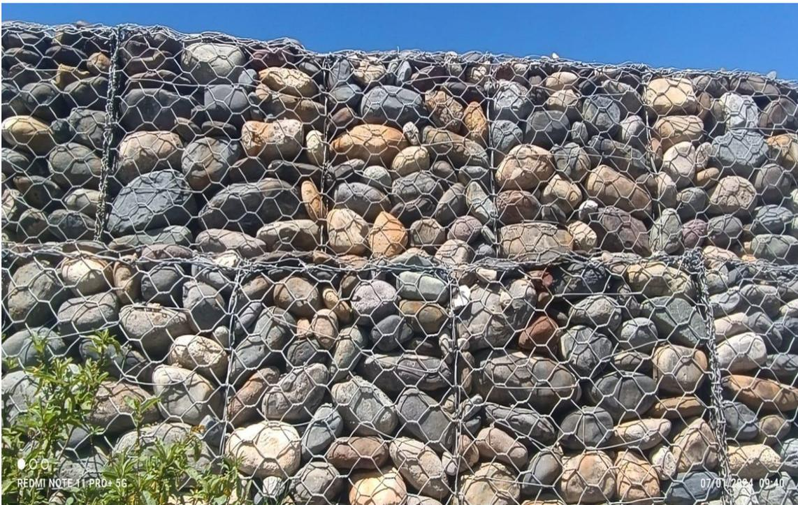
**FOTOGRAFIA 19:** En la imagen se observa la oxidación de la malla.
