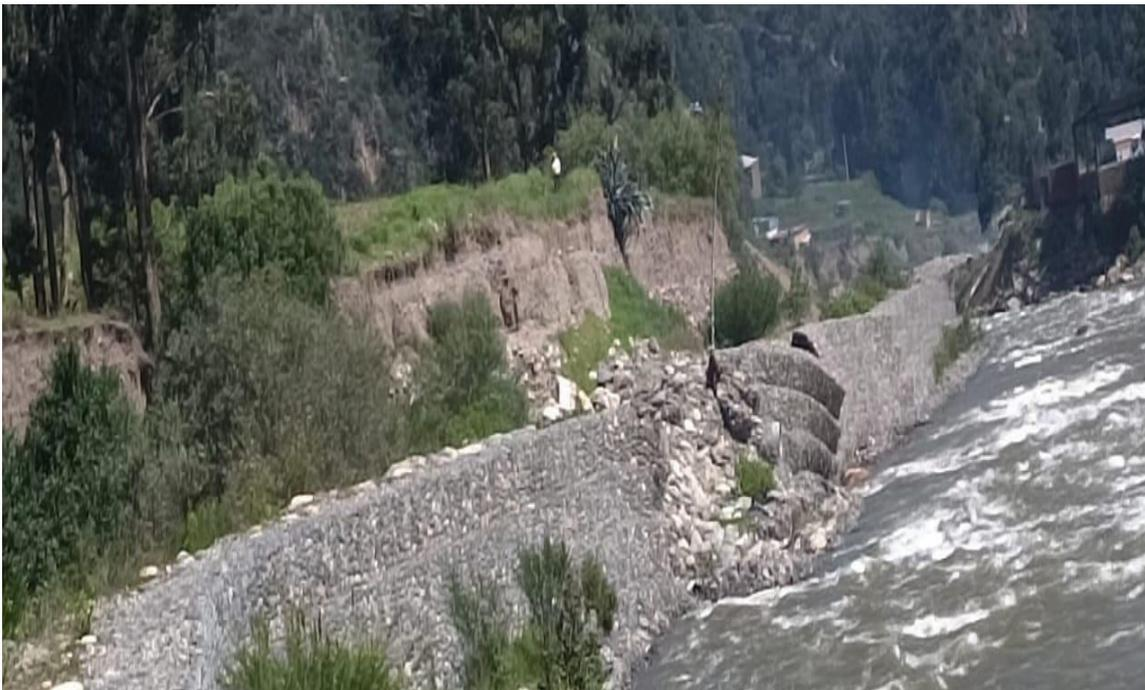
**FOTOGRAFIA 06:** En la imagen se observa el volteo del muro de gavión.
