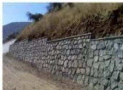
Figura 4. Muro de contención de mampostería
