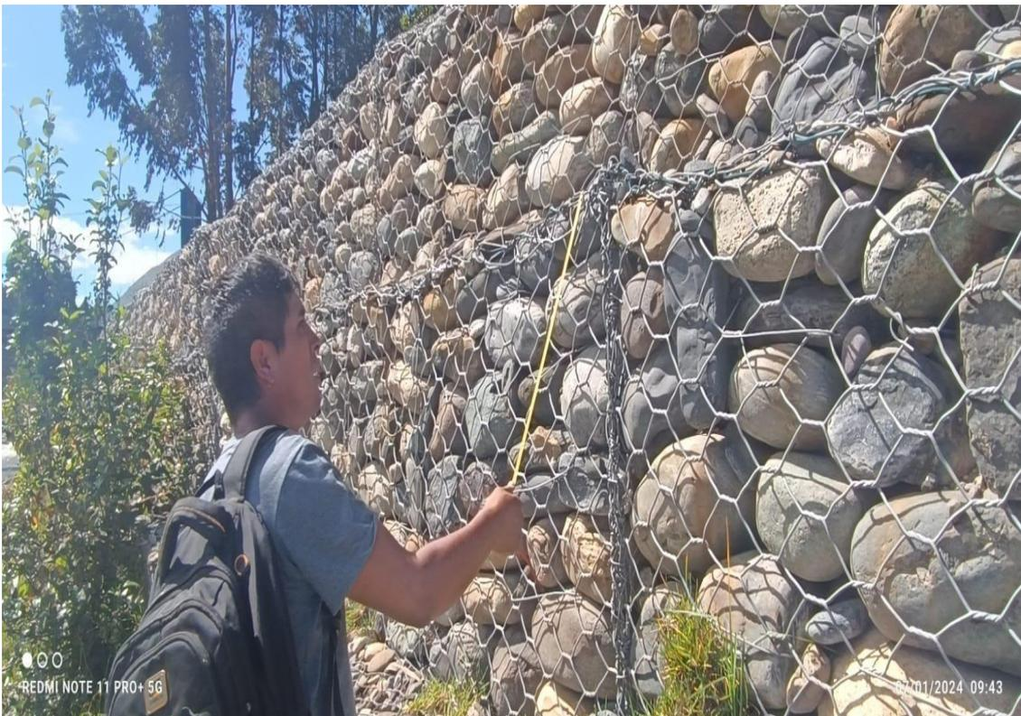
**FOTOGRAFIA 08:** En la imagen se observa que los tamaños de las rocas son pequeñas y sobrepasan fácilmente la abertura de la malla.
