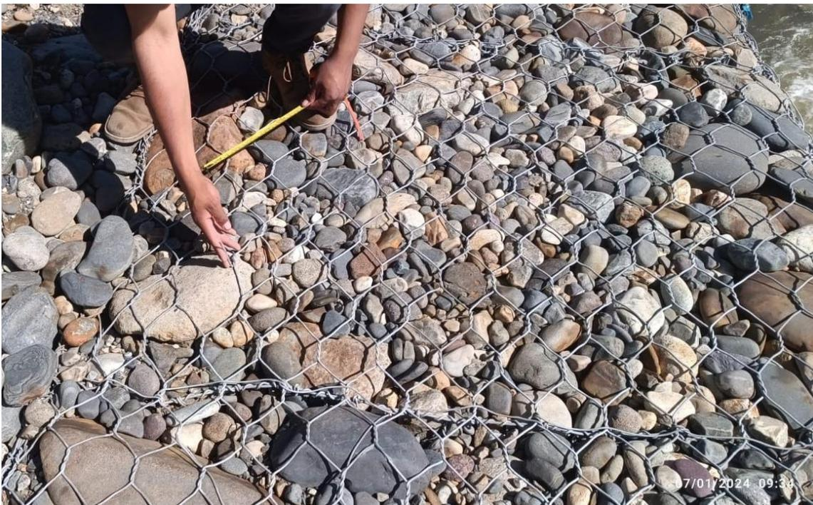
**FOTOGRAFIA 02:** Se observa la figura el rompimiento de las mallas de la progresiva 0+000 + 0+020 metros.
