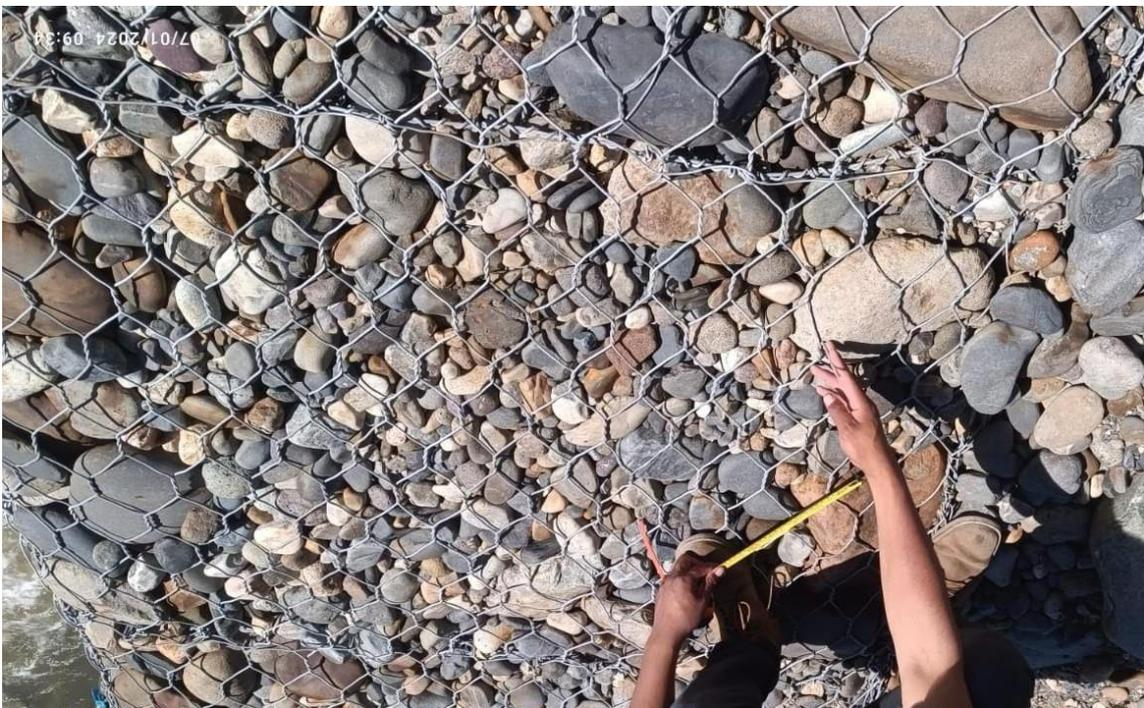
**FOTOGRAFIA 13:** En la imagen se observa la oxidación de la malla.
