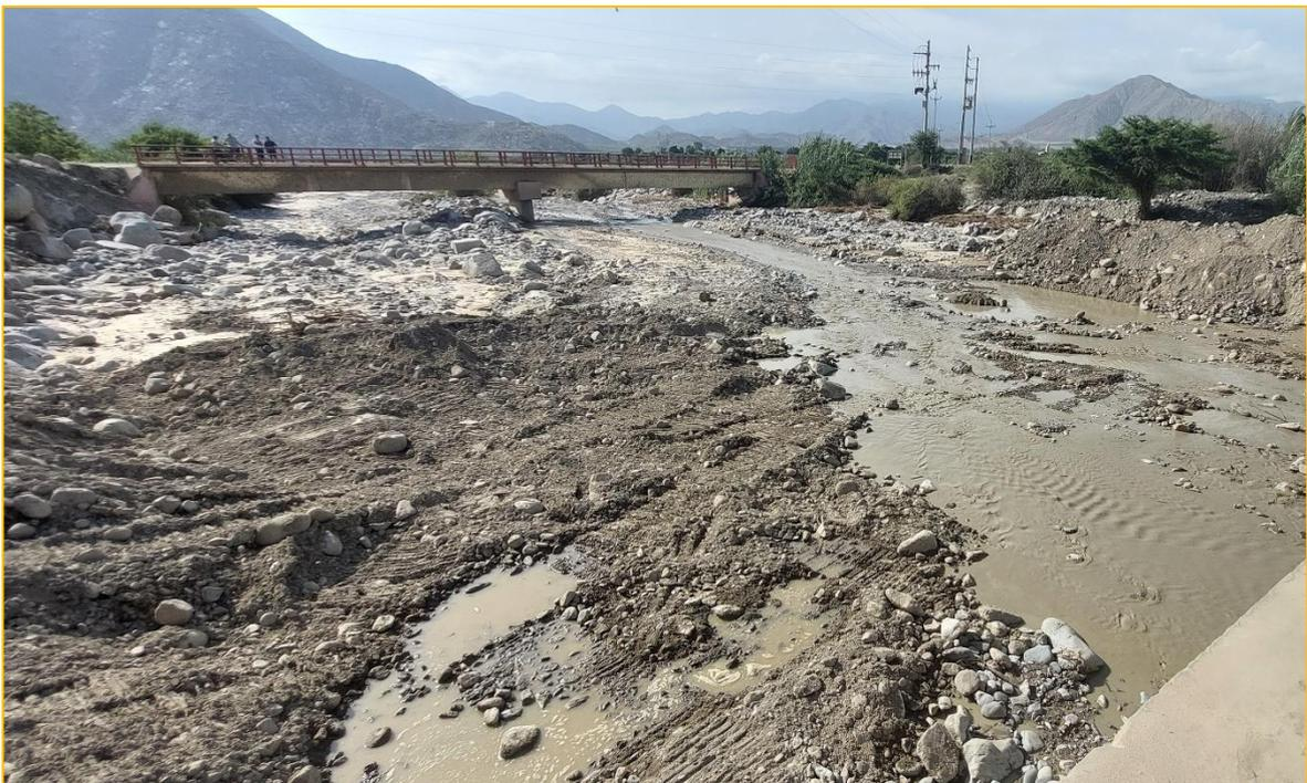
**Fotografía 02:** Se observa el rio loco en la parte izquierda socavando el talud
