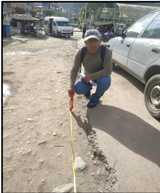
figura 29: Realizando la observación del enrocado en la progresiva 00+103 mts Fuente: Elaboración propia.
