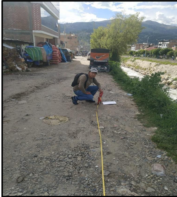
figura 22: Medición de la progresiva 00+43 mts. Fuente: Elaboración propia.
