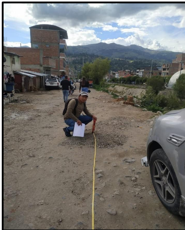
figura 20: Medición de la progresiva 00+23 mts. Fuente: Elaboración propia.
