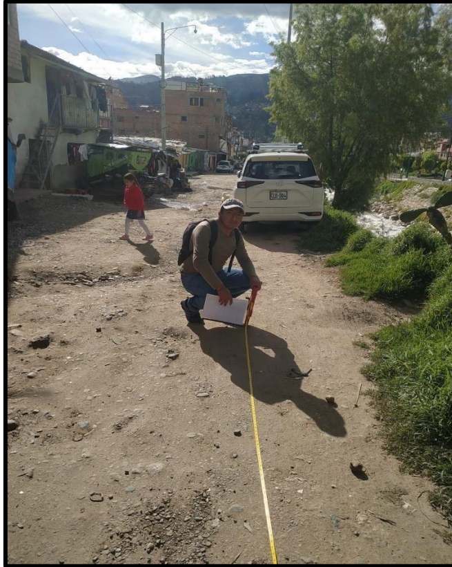
figura 24: Medición de la progresiva 00+63 mts Fuente: Elaboración propia.
