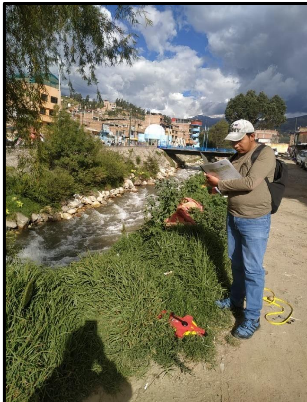
figura 25: Realizando la observación del enrocado en la progresiva 00+63 mts Fuente: Elaboración propia.
