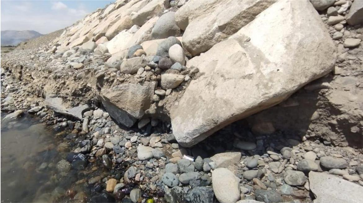
**Figura N° 6:** Enrocado de la margen derecha del rio, enrocado vulnerable progresiva 0+160 a 0+205
