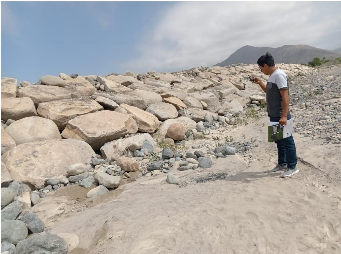
**Figura N° 2:** Enrocado de la margen derecha del río, zona vulnerable a erosión y desplome progresiva 0+000 a 0+110
