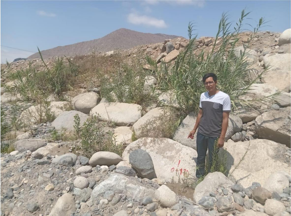
**Figura N° 5:** Enrocado de la Margen derecha del rio, zona con vegetación y desmonte progresiva 0+110 a 0+146
