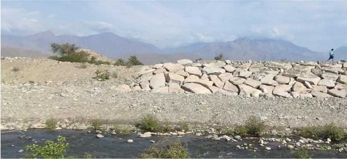
**Figura N° 7:** Enrocado de la margen izquierda del río (tramo sin enrocado progresiva 0+000 al 0+040)
