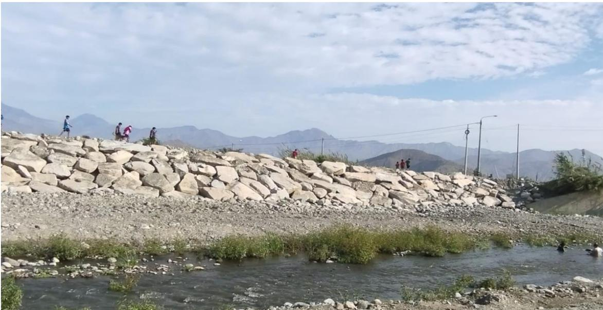
**Figura N° 8:** Enrocado de la margen izquierda del río zona vulnerable a desborde de río (progresiva 0+040 al 0+146)
