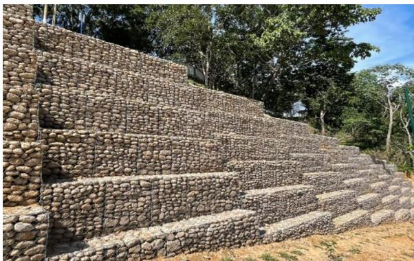
Figura 1. Muro de gavión tipo caja
