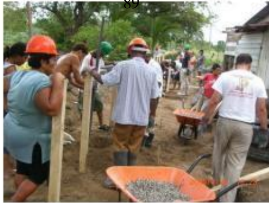
Foto 2. Colocación de las estacas de madera
