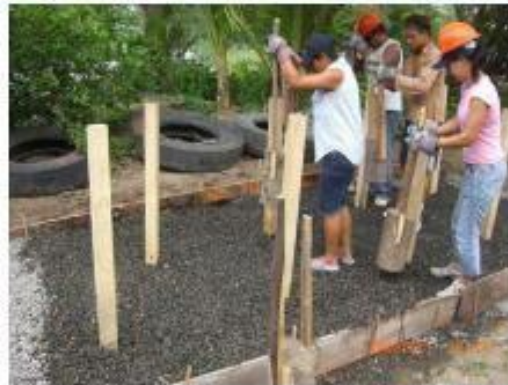
Foto 2. Colocación de las estacas de madera
