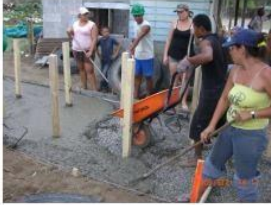
Foto 4. Aplicación de concreto para la cementación
