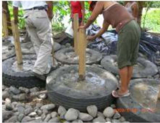
Foto 6. Aplicación mortero de cemento a las lantas previamente rellenas con grava.
