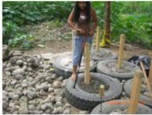
Foto 5. Colocación de llantas en el primer nivel y perforación de agujeros para pulgar aire
