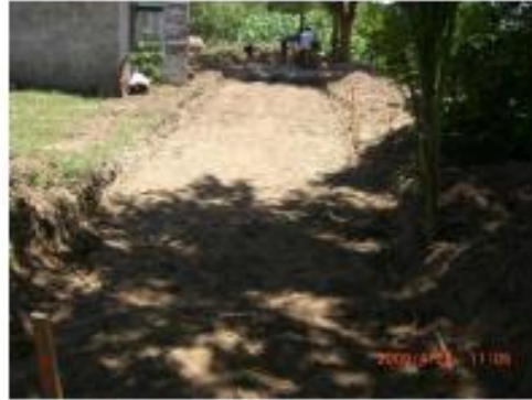
Foto 1. Excavación de la cimentación
