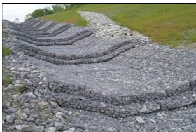
Figura N° 7: Gavión tipo Colchón
