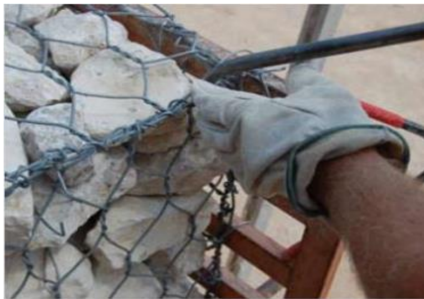
Figura N° 2: Proceso de montaje de gaviones
