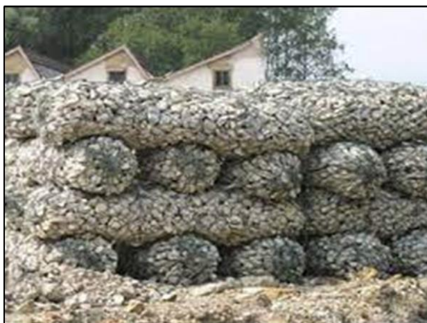
Figura N° 6: Gavión tipo saco
