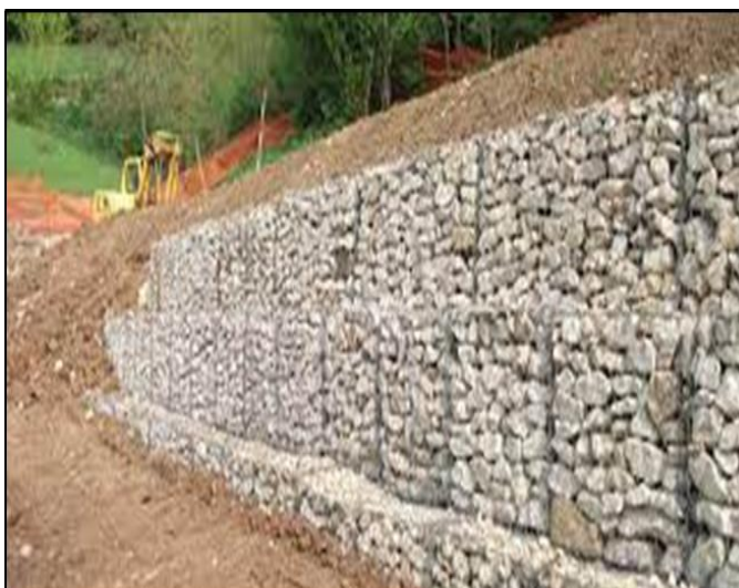
Figura N° 4: Gavión regularmente estructurados
