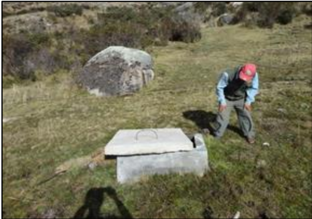
Ilustración 3: Cámara de rompepresión
